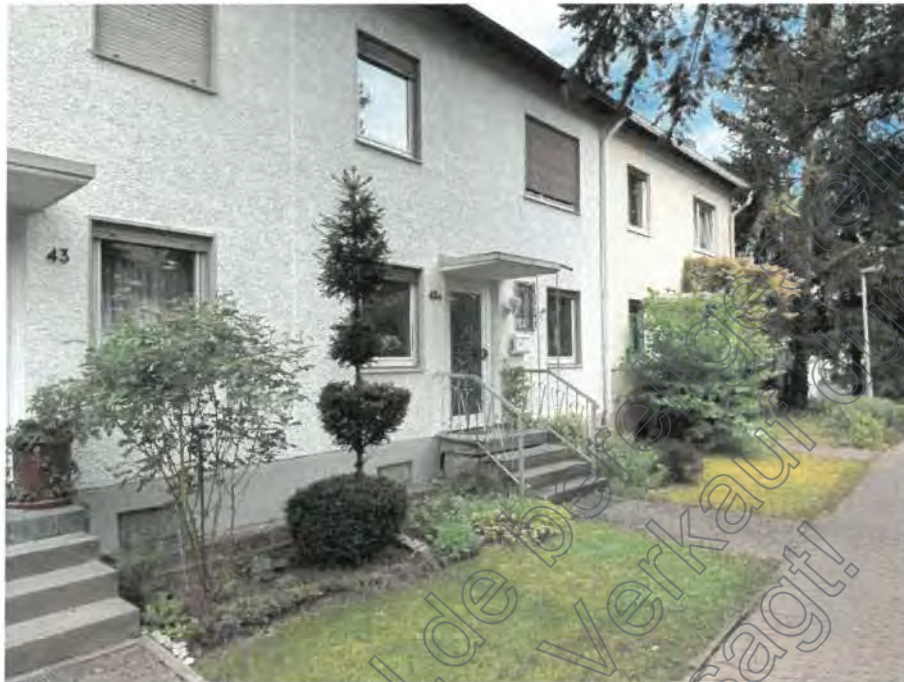
Bild 1: Blick auf das Bewertungsobjekt aus südöstlicher Richtung
