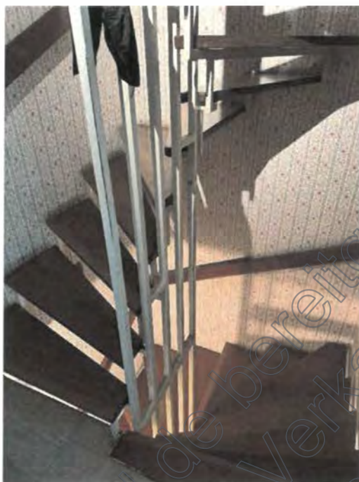
Bild 5: Blick auf die Geschosstreppe
