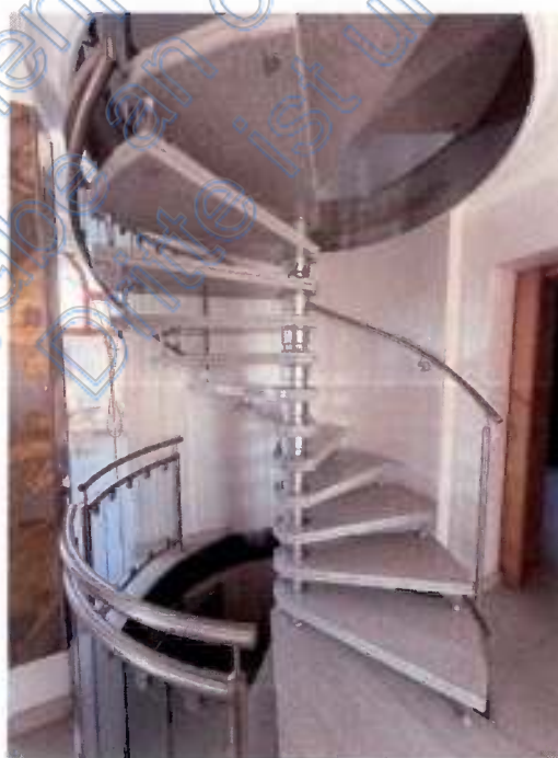
Bild 18: Blick auf die Wendeltreppe
