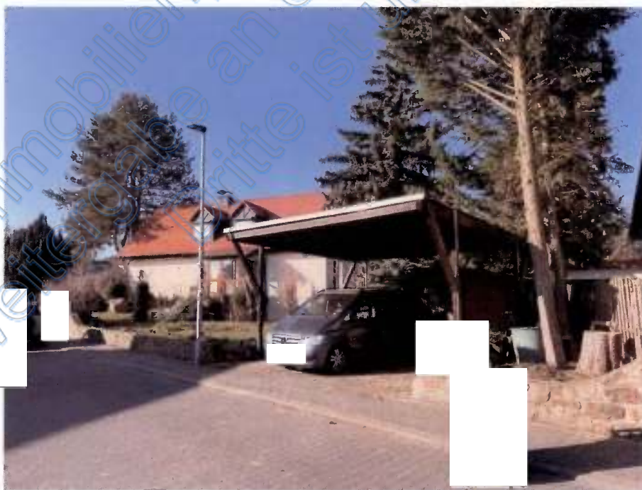
Bild 2: Blick auf das Bewertungsobjekt aus nordöstlicher Richtung
