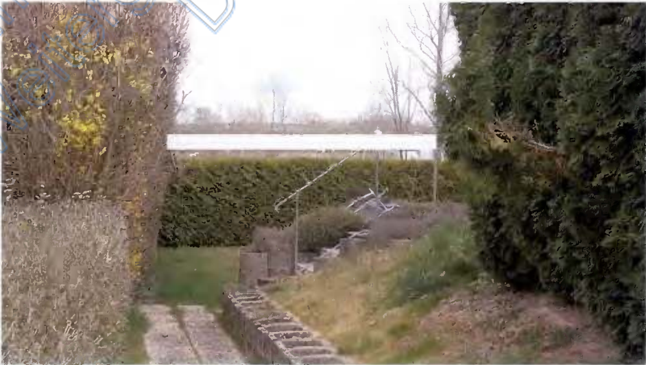
kleine Außentreppe zur erhöhten Terrasse
