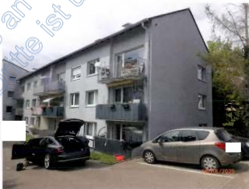
Ansicht von Süd-Osten
