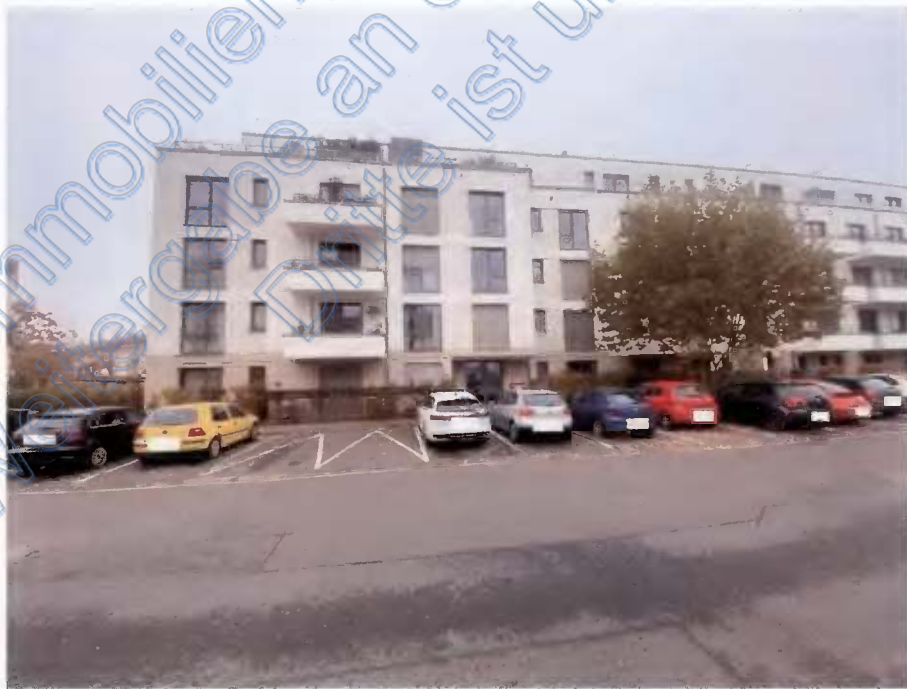
Bild 2: Blick auf einen Teilbereich der Wohnungs- und Teileigentumsanlage aus nordöstlicher Richtung
