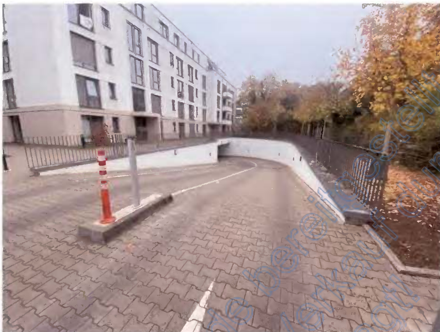
Bild 5: Blick auf die Zu- und Ausfahrt der Tiefgarage
