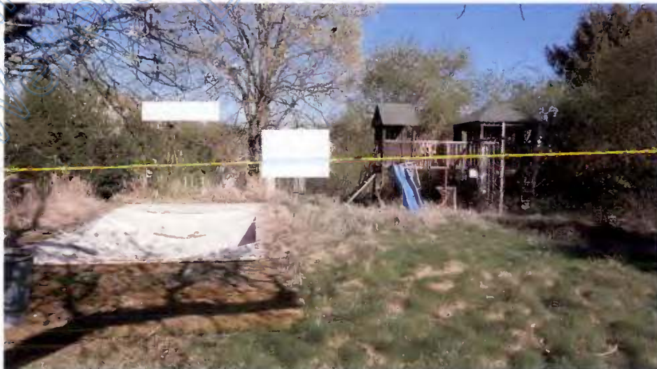
hinterer Gartenbereich mit sanierungsbedürftigem Freischwimmbecken
