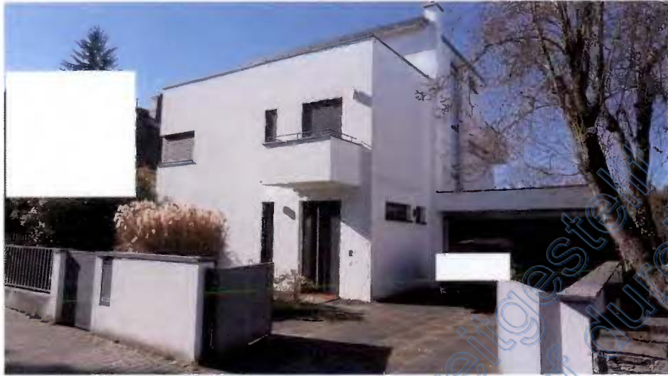
Wohngebäude mit Doppelgarage
