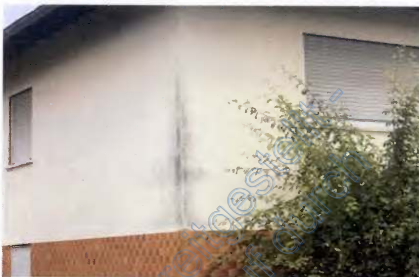
Abb. 3: Foto des SV; z.T. Fassade mit deutlichen Putzverfärbungen
