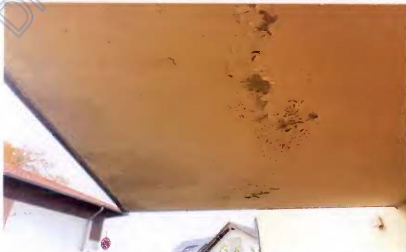
Abb. 5: Foto des SV; z.T. Vordach Kellereingang schadhaft (unterseitige Ablösung der Farbbeschichtung, Farbablösungen)
