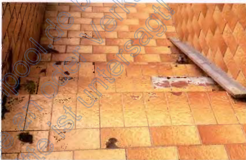
Abb. 4: Foto des SV; z.T. Fliesenbelag der Kelleraußentreppe schadhaft
