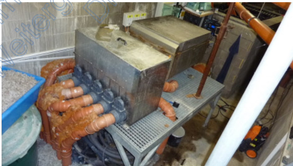
Koianlage mit erhebl. Technik unter einer betonierte KG-Fläche, die als Überbau auf Nachbargrundstück Nr. 323/1 und Bewertungsgrundstück Nr. 323/2 liegt.
