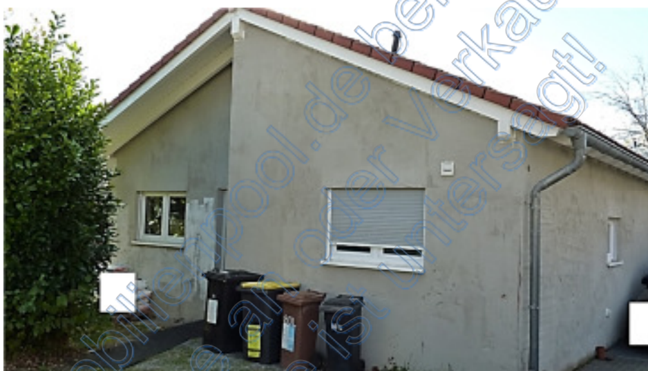
Fassade nur mit Unterputz / endgültiger Putz fehlt noch
