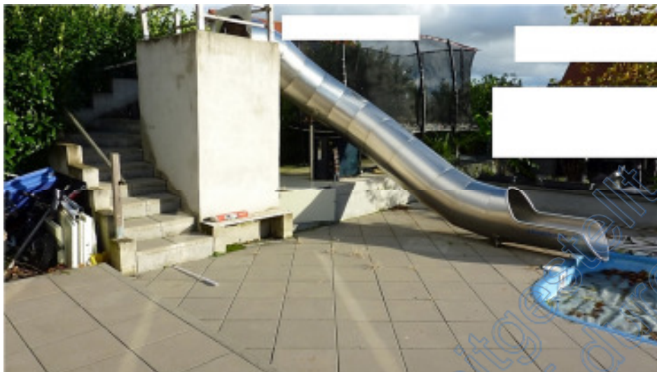
Treppenturm mit Rutsche zum Schwimmbad
