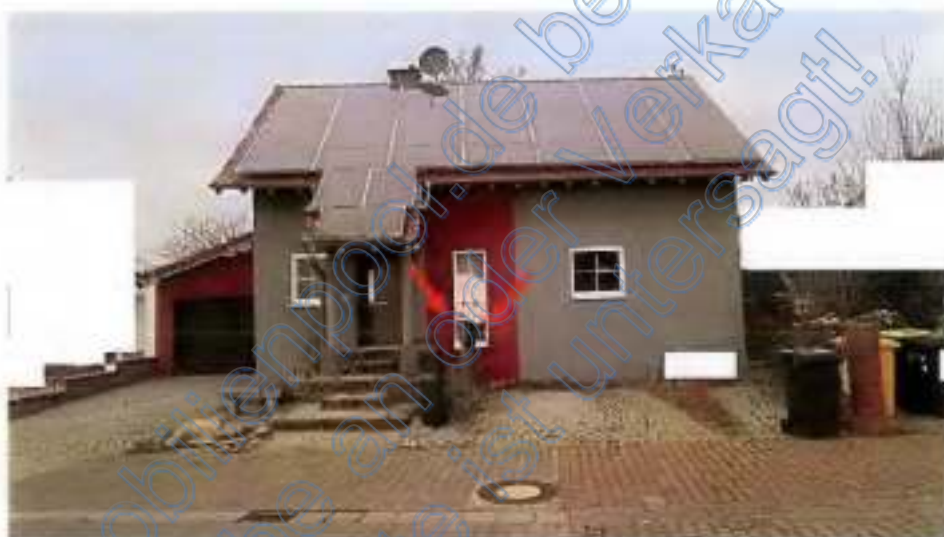
Straßenansicht / Photovoltaikanlage und Wallbox zur PKW-Aufladung
