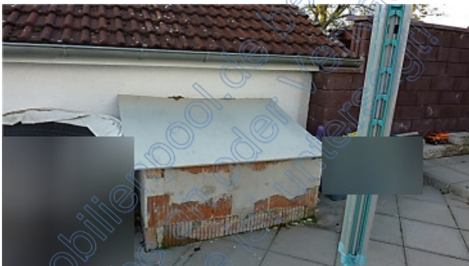
unverputzte Box für Schwimmbadtechnik
