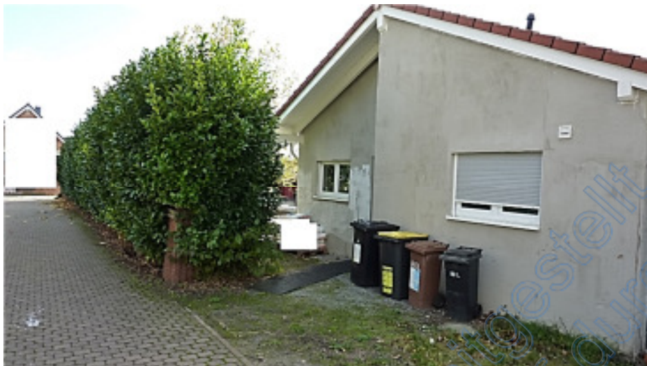
Eingangsbereich – Wegebefestigung noch nicht vorhanden / Vorgarten noch anzulegen
