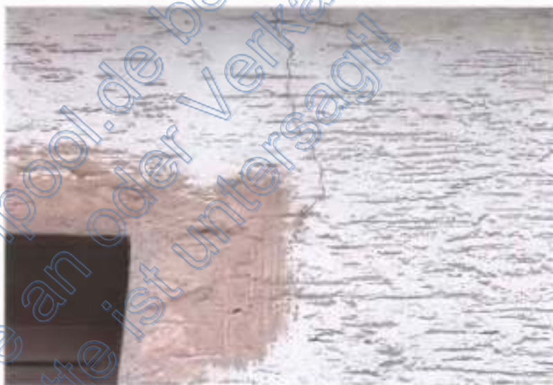
Abb. 4: Foto des SV; z.T. Fassade schadhaft (Putzrisse)
