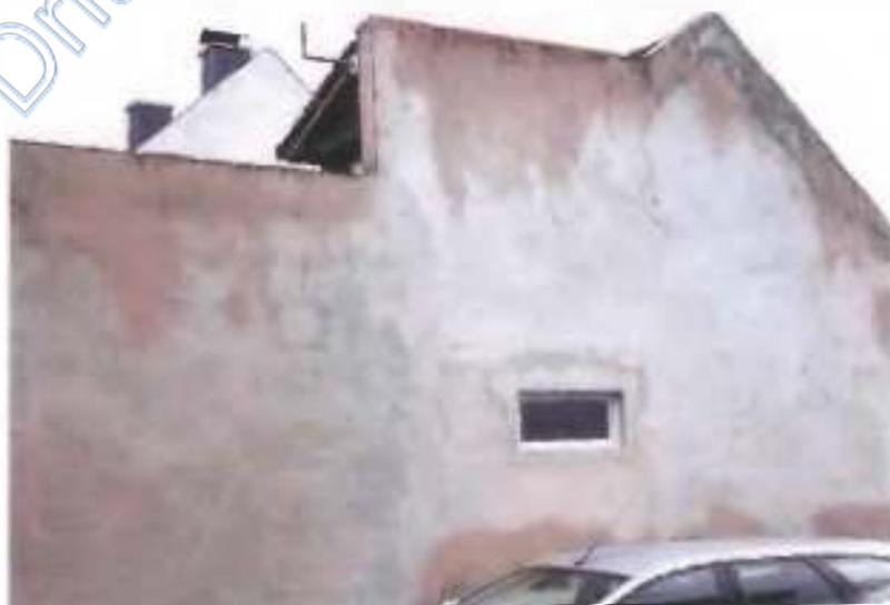
Abb. 8: Foto des SV; z.T. Fassade schadhaft (Putzrisse, Feuchteschäden)
