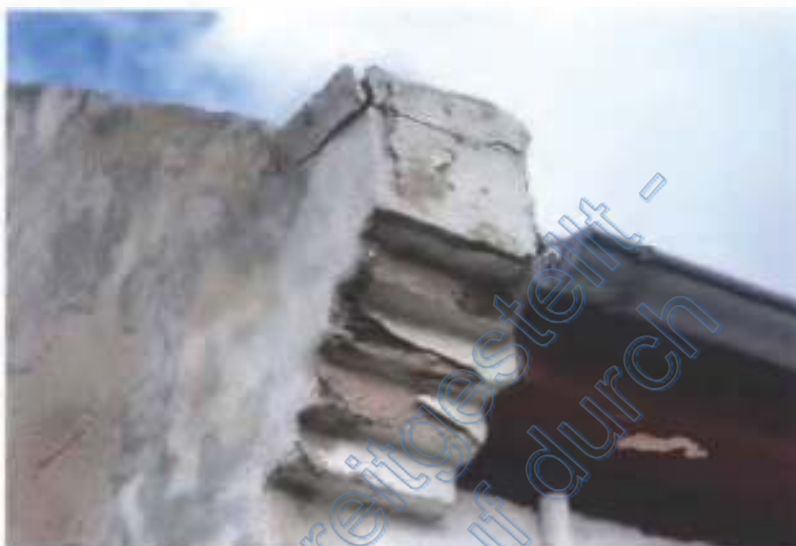
Abb. 6: Foto des SV; z.T. Fassade schadhaft (Putzabplatzungen)
