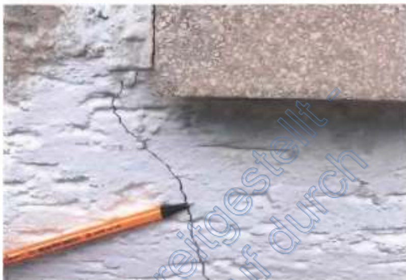
Abb. 3: Foto des SV; z.T. Fassade schadhaft (Putzrisse)
