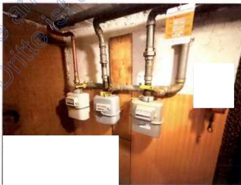
Foto 10 des SV: Kellergeschoss, Technikraum
