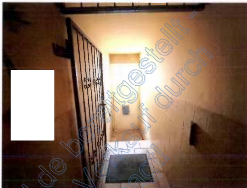
Foto 3 des SV: Treppenhaus, Hauseingang
