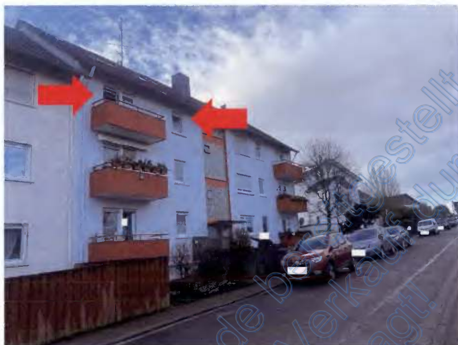
Bild 1: Blick auf einen Teilbereich der Wohnungs- und Teileigentumsanlage aus nordöstlicher Richtung
