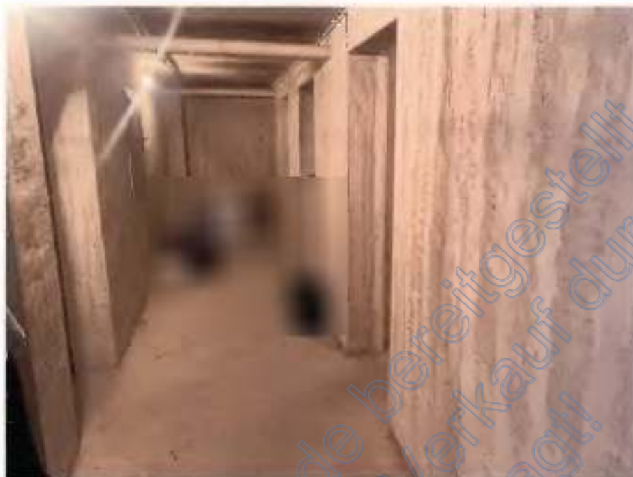
Bild 5: Blick in einen Kellerflur
