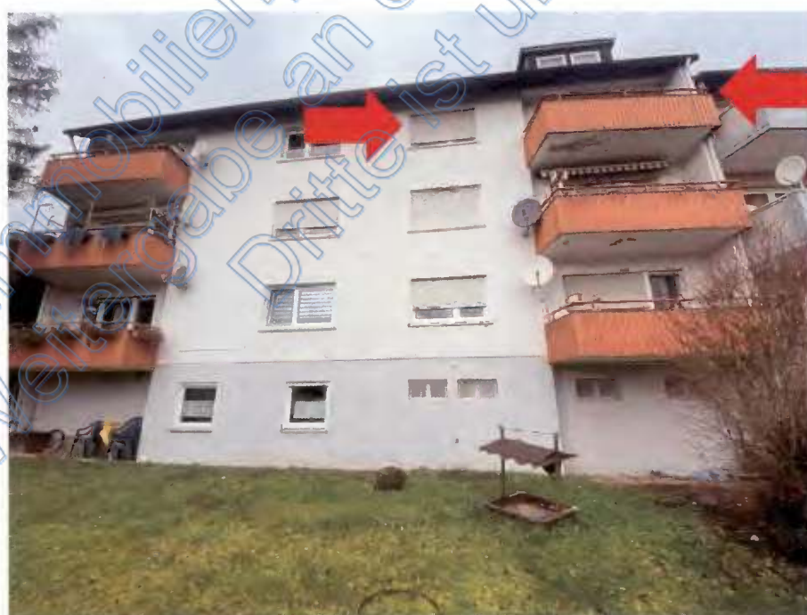
Bild 2: Blick auf einen Teilbereich der Wohnungs- und Teileigentumsanlage aus südlicher Richtung
