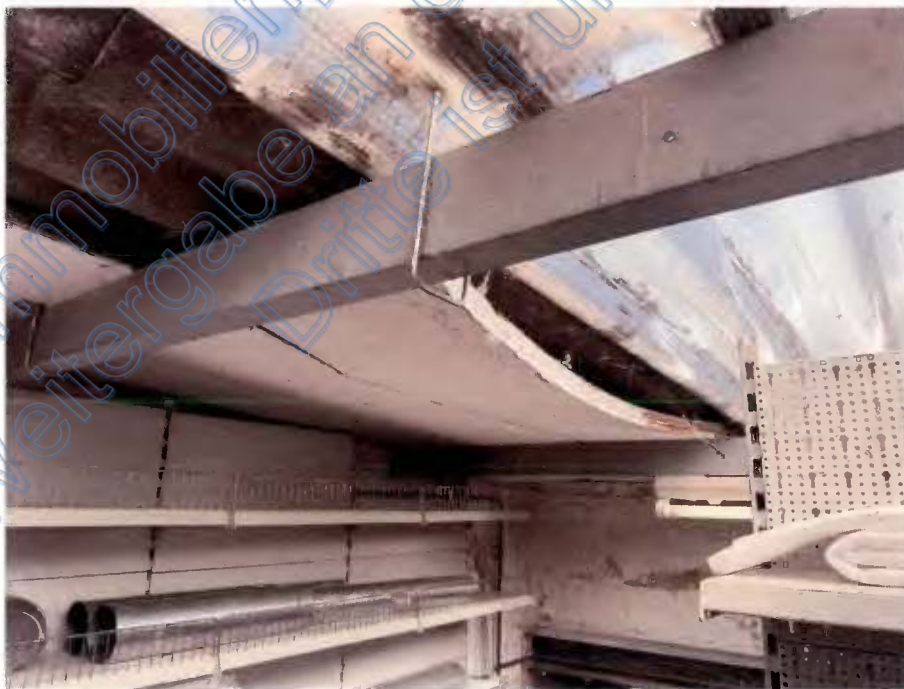
Bild 14: Blick auf bereichsweise schadhaften/fehlenden Deckenbelag im Werkstatt-/Lagerbereich
