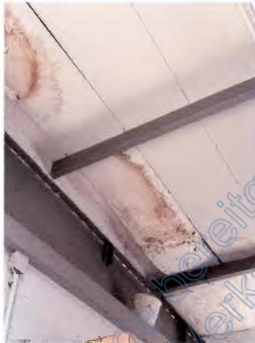
Bild 13: Blick auf den Feuchtigkeitsschaden im Werkstatt-/Lagerbereich
