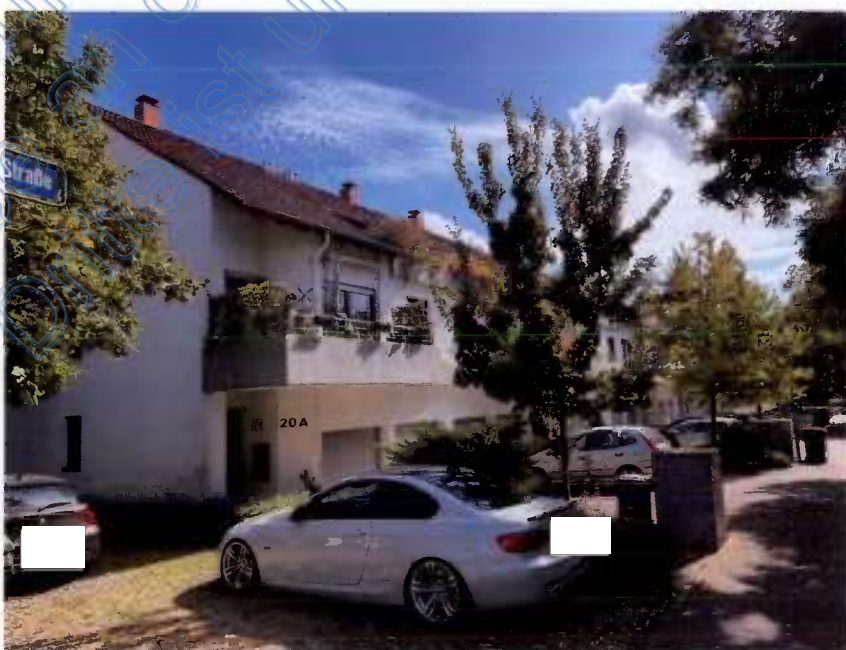
Foto 2 des SV: Wohngebäude Henry-Moisand-Straße 16, 18 A, 20, 20 A; Ansicht von Nordwesten
