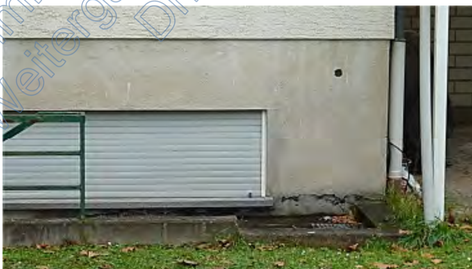
Haussockel partiell mit Schadstellen / Feuchteschaden
