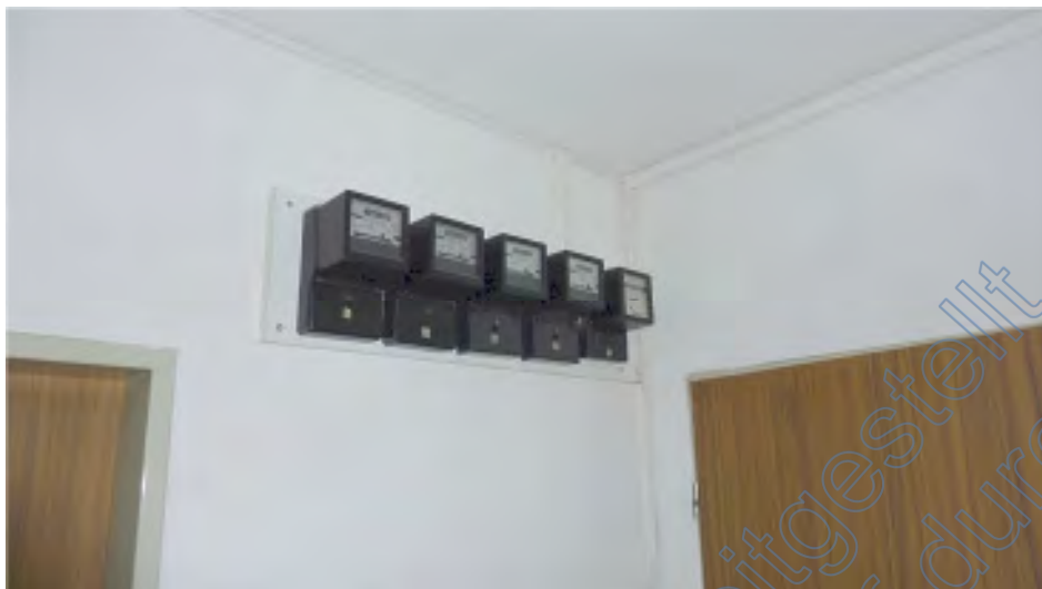
Elektro-Zwischenzähler
