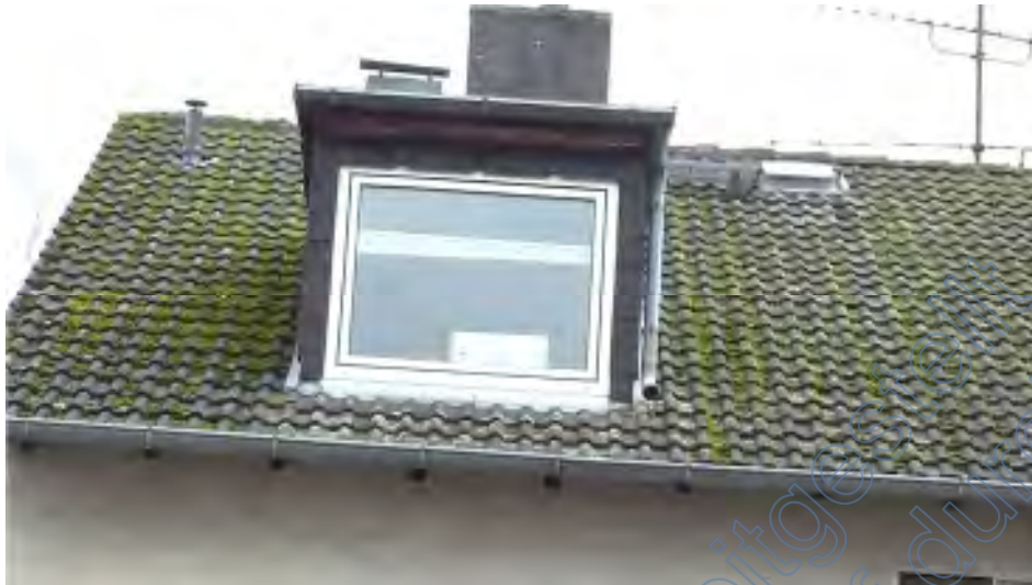
Dachbereich mit Betondachziegeln und vermoosten Stellen
