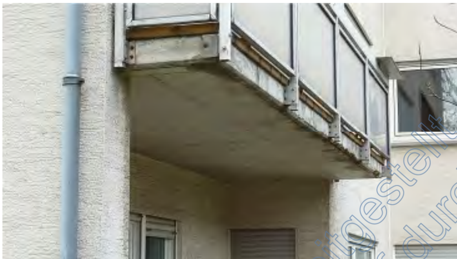
Balkon mit Feuchteschäden / Betonschäden im Randbereich
