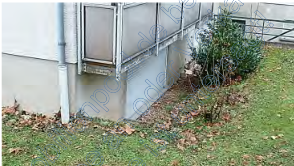
Fenster der Kellerzimmer / Balkonkante mit Schadstellen
