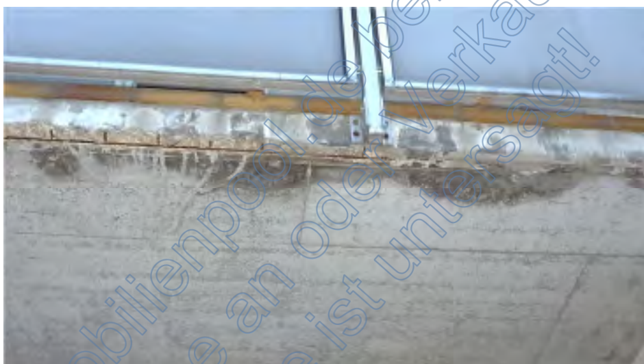
Balkon mit Feuchteschäden / Betonschäden mit tlw. freiliegender korrodierter Bewehrung
