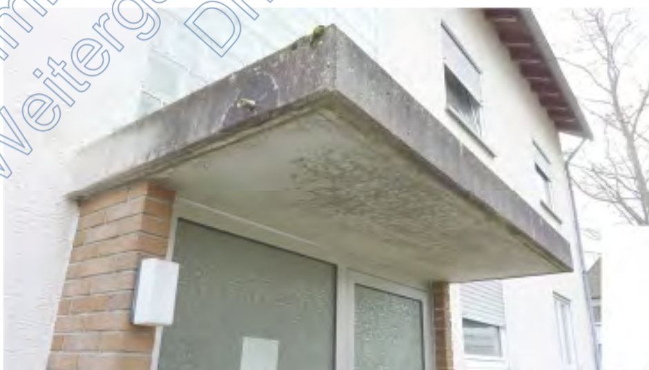
einf. Vordach mit Abnutz.ersch. / Feuchteschaden
