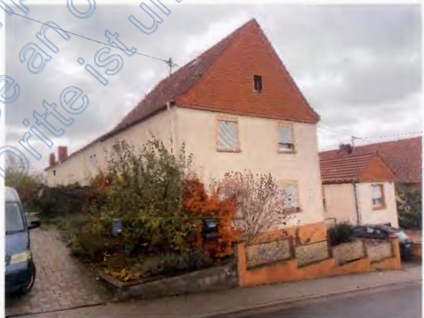
Foto 2 des SV: Ansicht von Nordwesten
