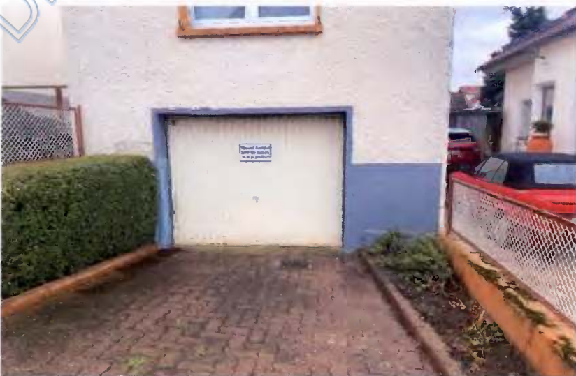
Foto 7 des SV: Nebengebäude, Garage KG
