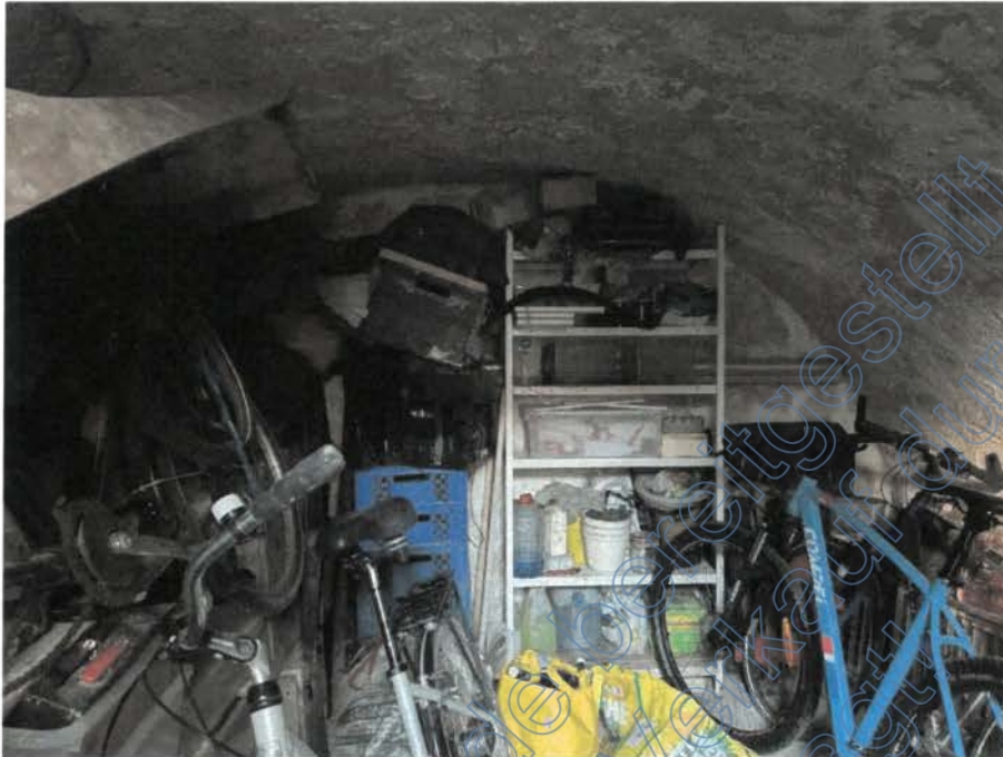
Bild 5: Blick in das Keller-/Lagergebäude
