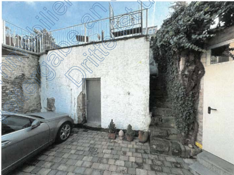
Bild 2: Blick auf das Keller-/Lagergebäude aus westlicher Richtung
