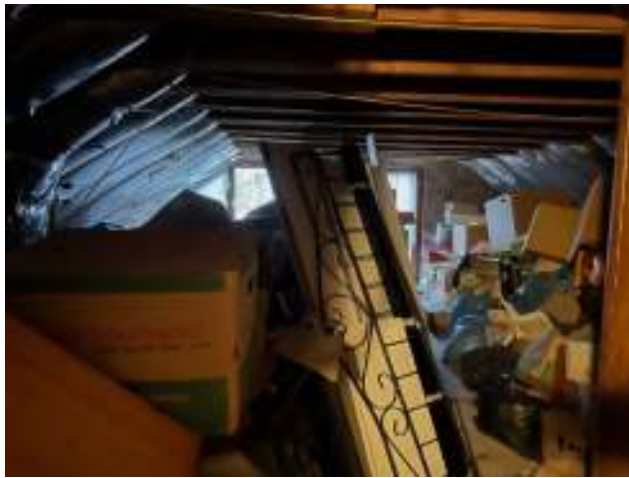
Zustand Dachboden (allgemein)
