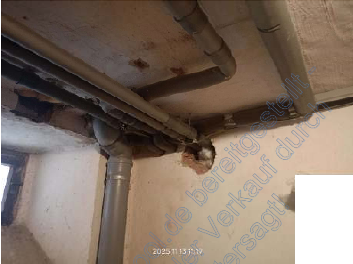
Durchbrüche im Kellergeschoss bezüglich Versorgungstechnik
