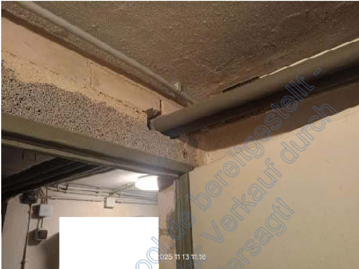
Durchbrüche im Kellergeschoss bezüglich Versorgungstechnik
