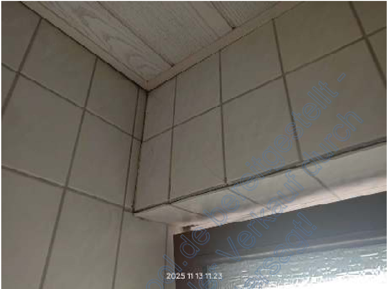
Außenwandbereich im Innenraum des Wohngebäudes mit exemplarischer Darstellung des Instandhaltungszustaus.
