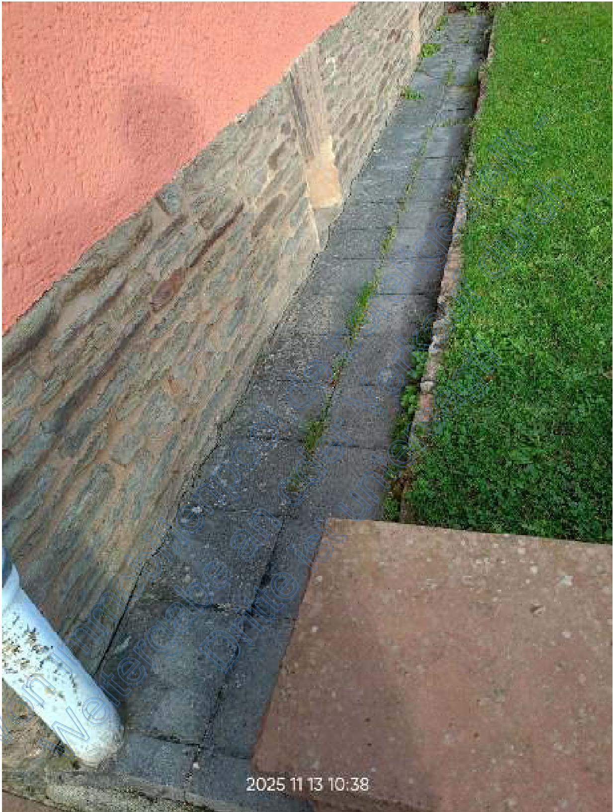
Sockelbereich des Bewertungsobjekts zur Straßenseite hin.
