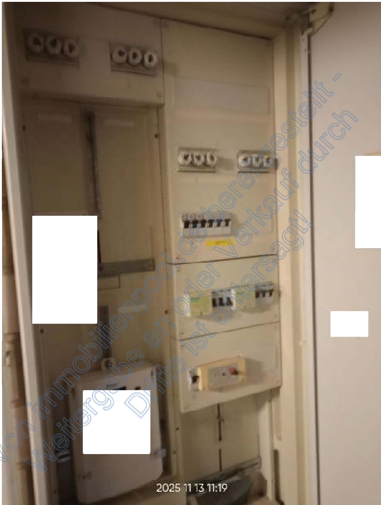
Sicherungskasten
