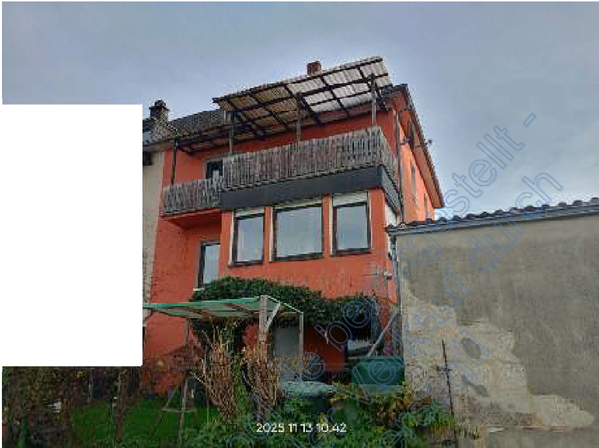
Blick auf das Bewertungsobjekt (Wohngebäude und Garagenstellplatz) und die Nachbarbebauung vom öffentlich zugänglichen, rückwärtigen Bereich.
