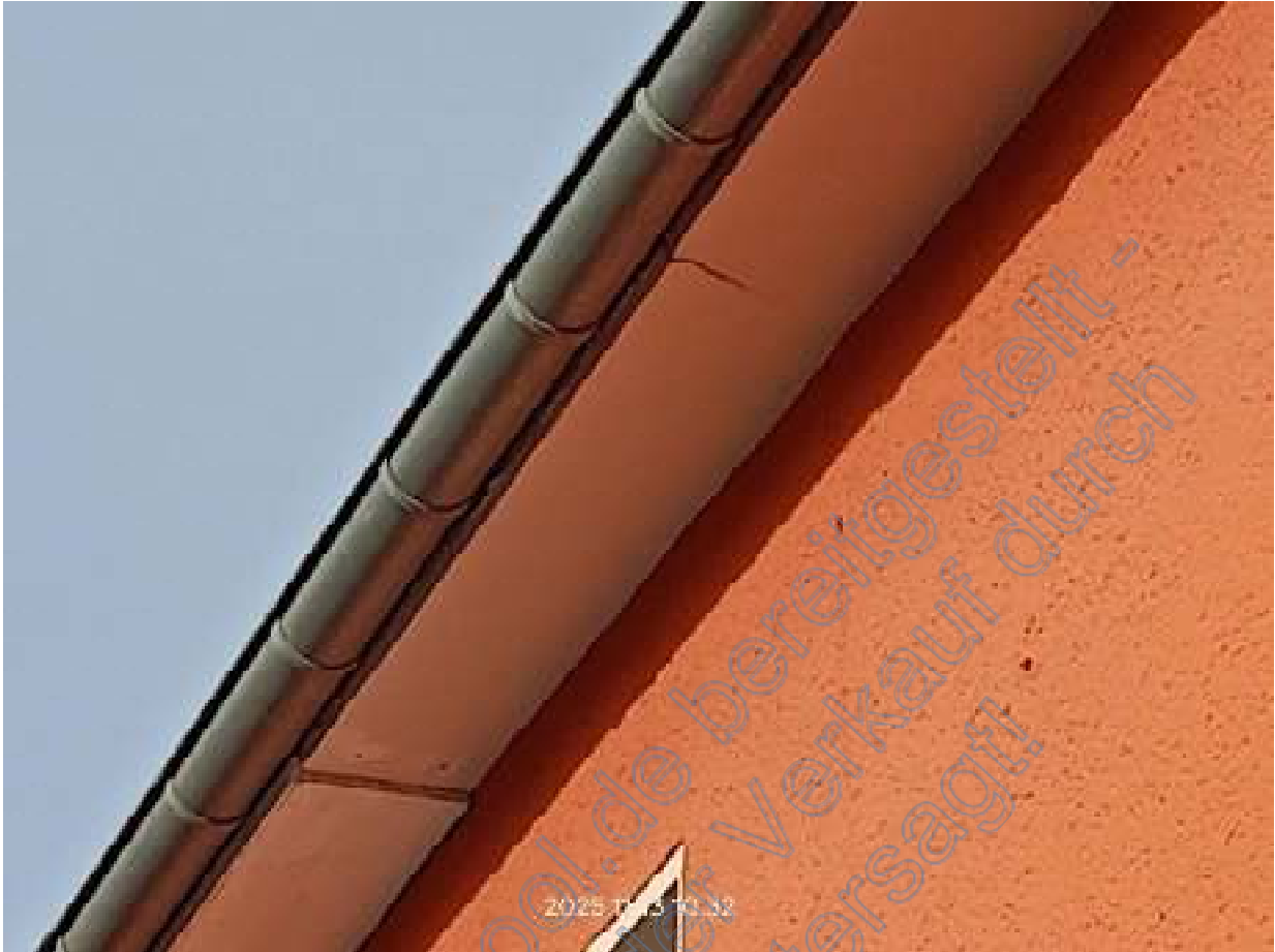
Traufe des Bewertungsobjekts mit exemplarischer Darstellung des Erhaltungszustands bzw. Baumängel.
