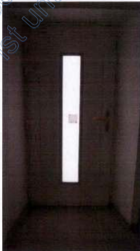
Erdgeschoss Innenansicht Haustür
