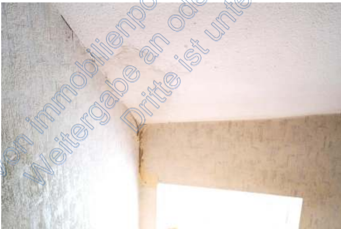
Wasserschaden Treppenhaus
