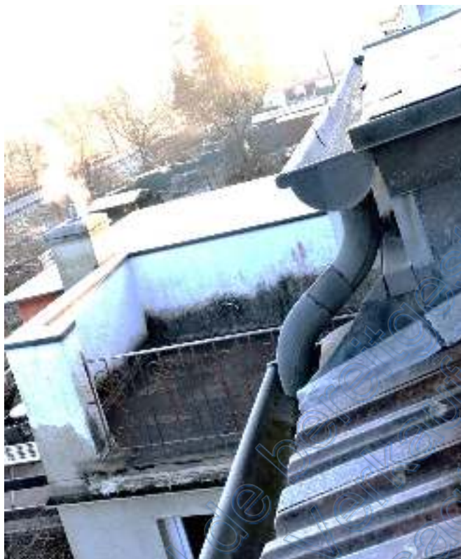
Ansicht Balkon Flachdach / Anbau
