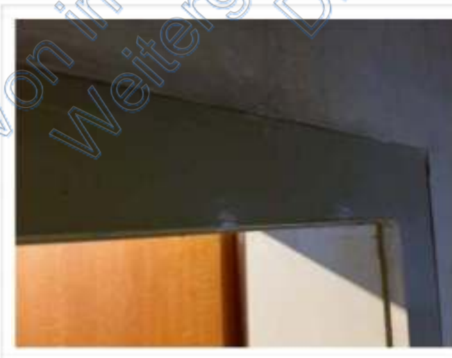
Zustand Türen (innen)
