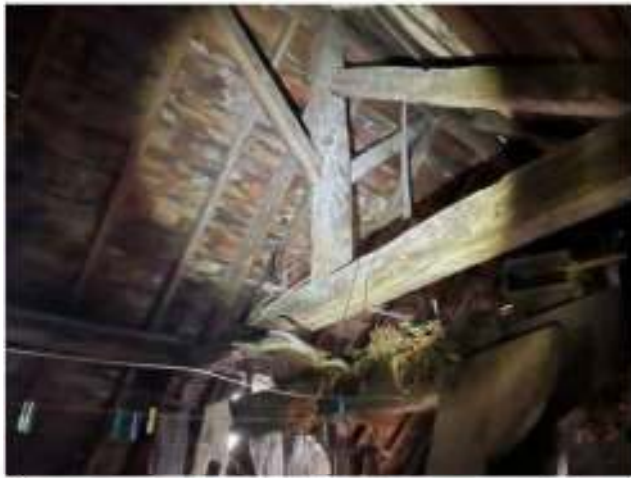
Zustand Dachboden (allgemein)
