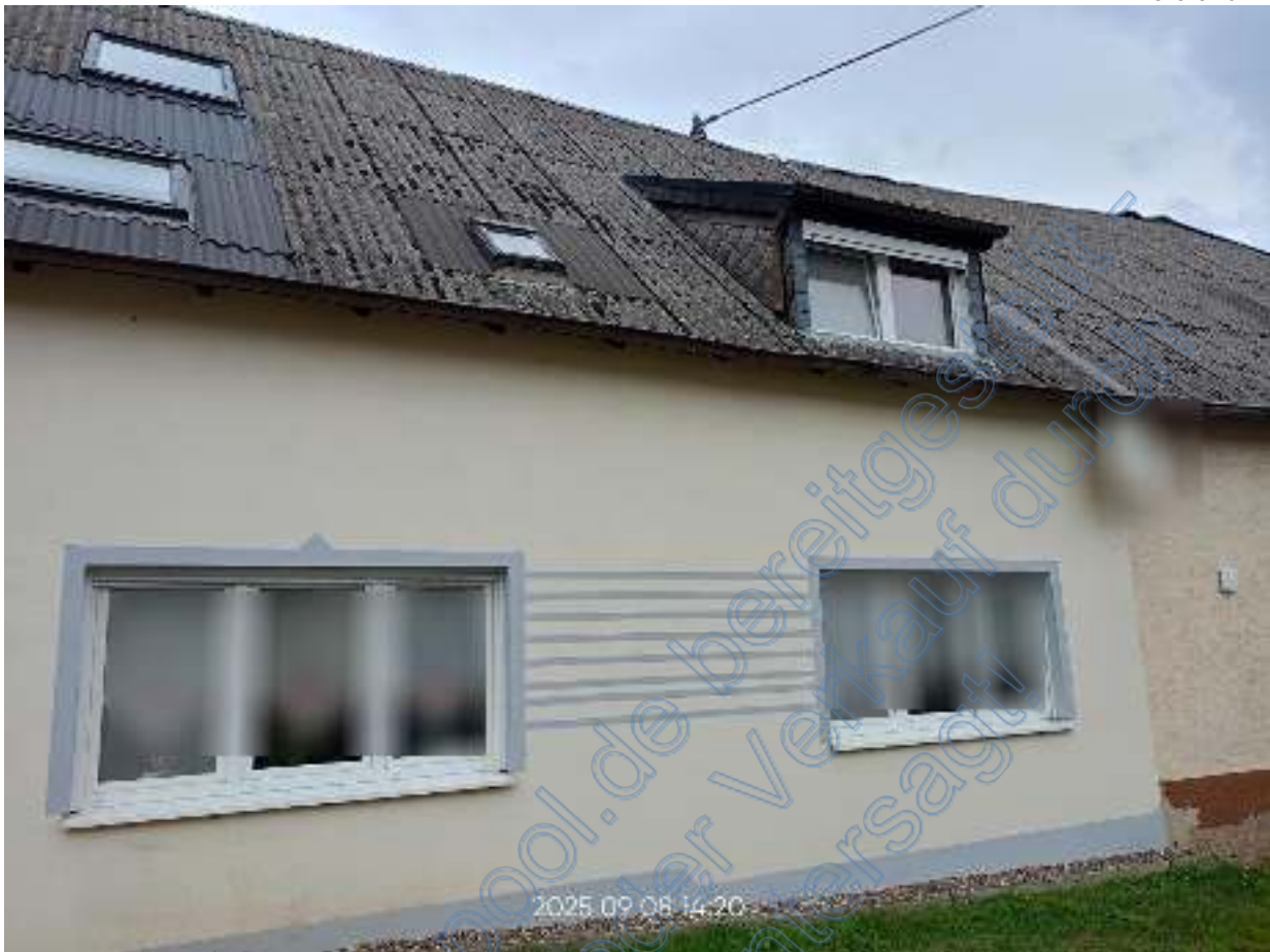
Gaube zum Straßenbereich.
