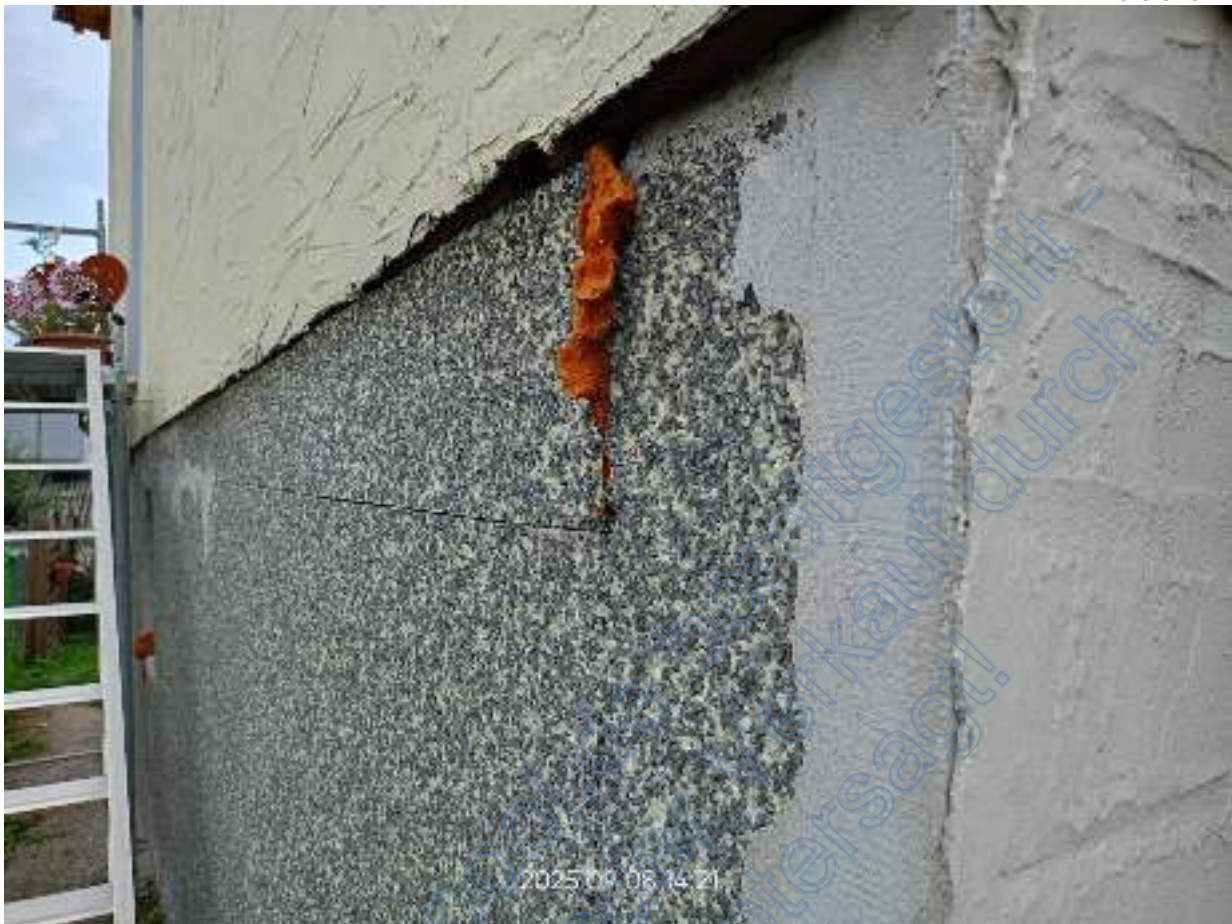
Zugang zur Einliegerwohnung i m1.OG mit Blick auf die Dämmung der Garage.
