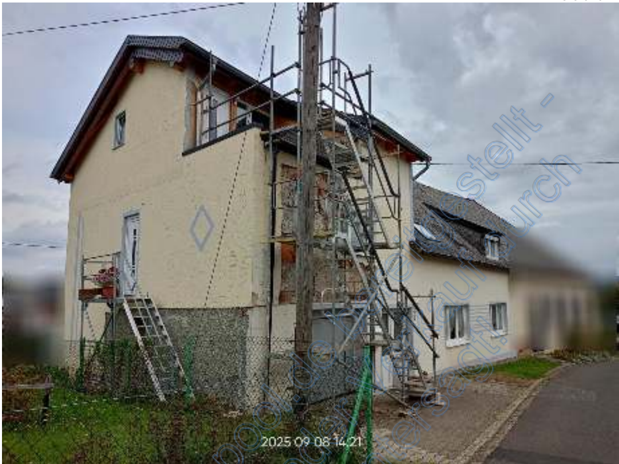
Bewertungsobjekt mit Blick auf die Erschließung der Einliegerwohnungen über Baugerüste.
