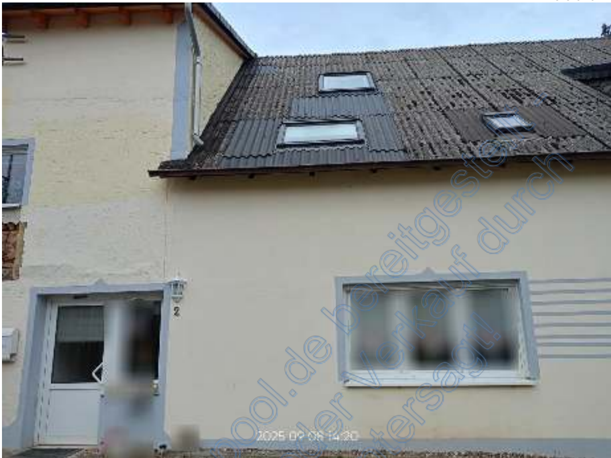
Blick auf Teile der Fassade von Straßenseite und Dachfläche.
