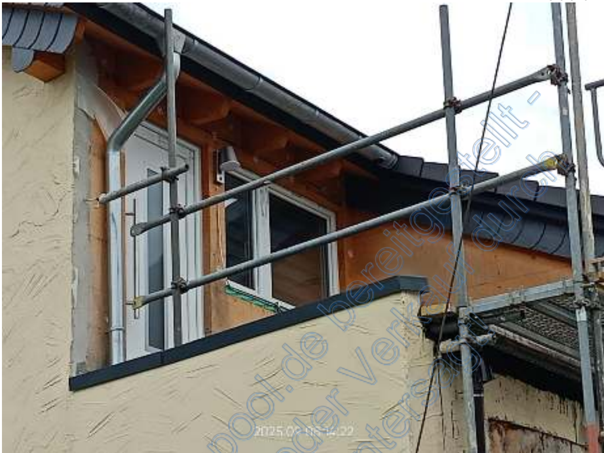
Zugang zur Einliegerwohnung im Dachgeschoss mit Elektroinstallation auf der Dämmschicht.
