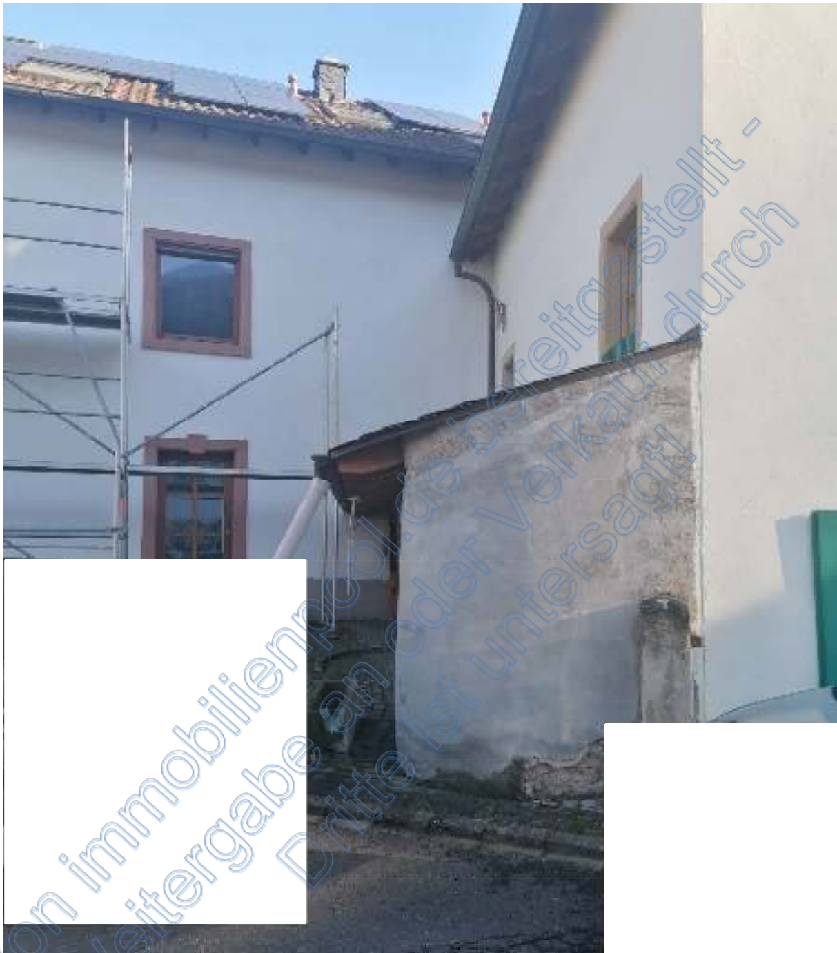
Abbildung 16 – Zugangsbereich zwischen Hausnummer 10a (Gebäude in dem das zu bewertende Sondereigentum verortet ist) und Hausnummer 10 mit Anbau.
