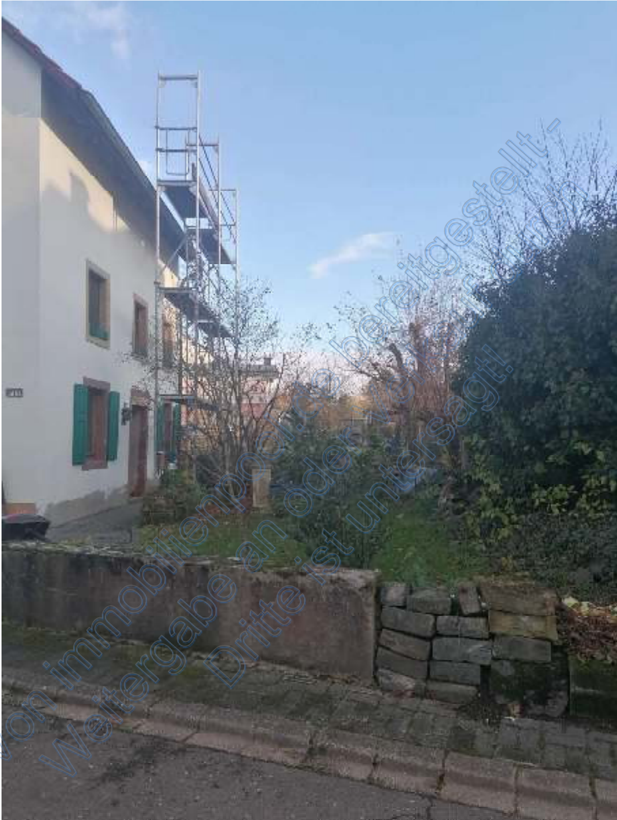
Abbildung 19 - Blick auf die in der Baugenehmigung markierte Zufahrt zu den nicht vorhandenen Stellplätzen des zu bewertenden Sondernutzungsrechts und des Altbaus
