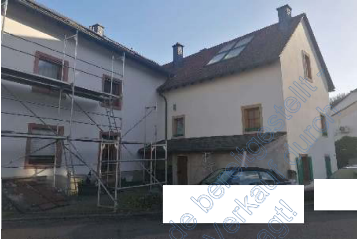
Abbildung 17 - Blick auf die eingerüstete Fassade und das zu bewertende Sondereigentum im 1.OG und das Altbauobjekt
