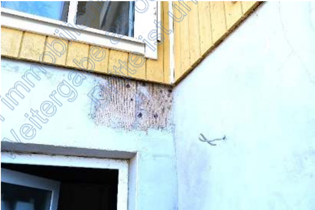
Schäden Außenputz
