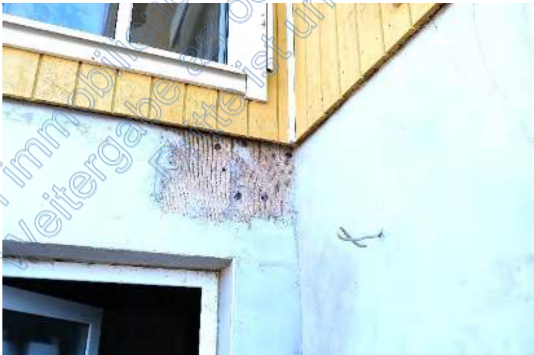
Schäden Außenputz
