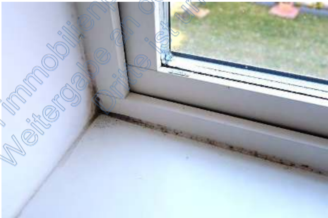
Feuchtigkeitsschäden Fenster OG
