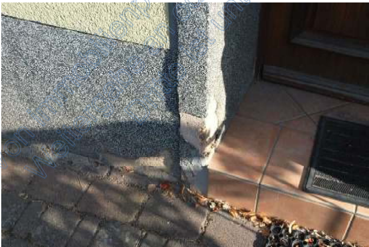
Sockelputz schadhaft
