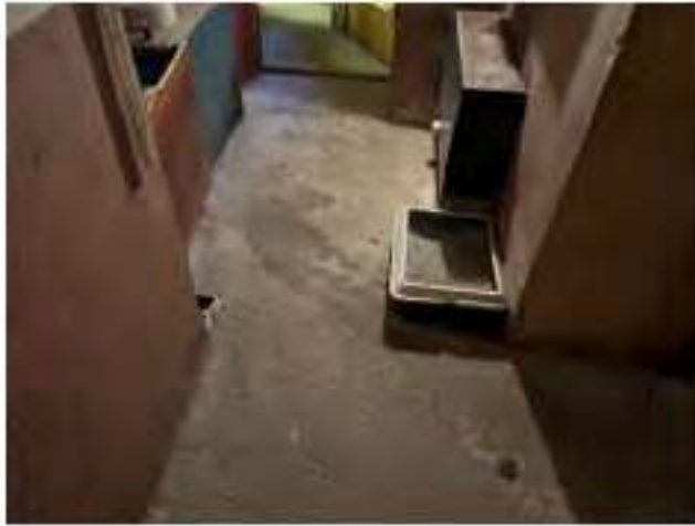
Zustand Keller (allgemein)
