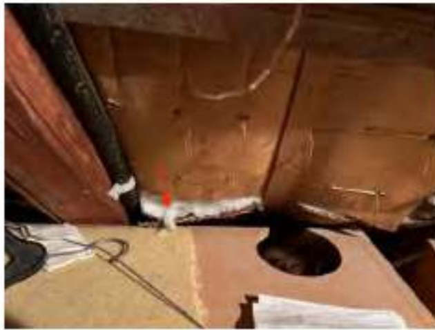
Zustand Dämmung (Dach)
