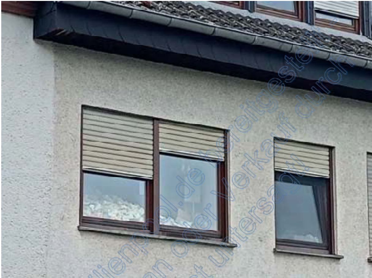
Abbildung 11 - Beschädigungen am Traufgesims in Gebäudeteil A
