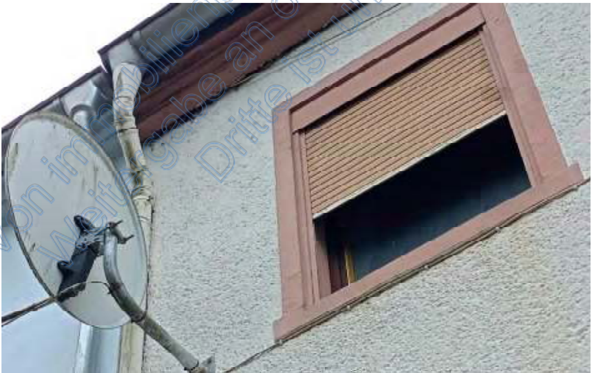
Abbildung 10 - Beschädigtes Traufgesims und Entwässerungssituation an Gebäudeteil A. Augenscheinlich herabhängende Kabelinstallationen.
