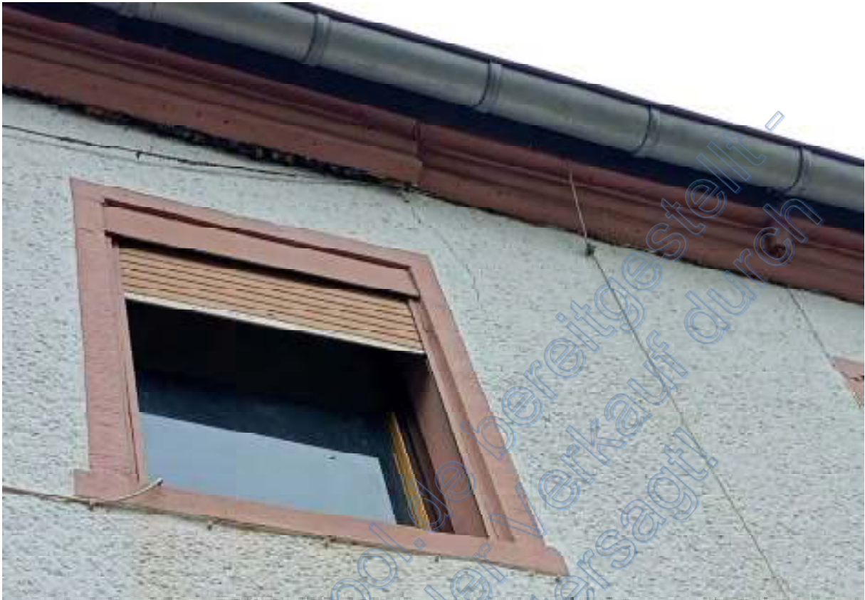
Abbildung 9 - Herunterhängendes Traufgesims mit der Witterung und potentiell Insekten zugänglicher Unterkonstruktion. Risse in der Bausubstanz.
