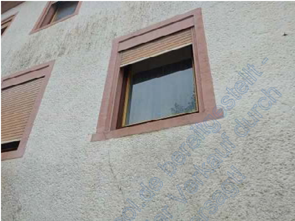
Abbildung 8 - Fenster und Fassade im Gebäudeteil B. Rissbildung, Abplatzung und Bewitterung an der Außenfassade
