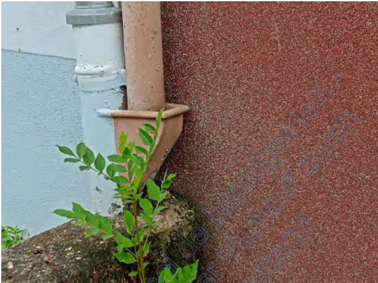
Abbildung 40 - Entwässerungssituation der Regenrinne von Gebäudeteil B mit Wildwuchs
