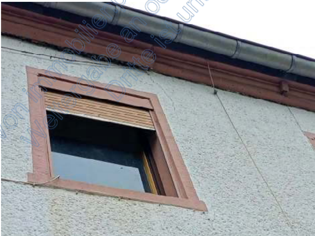
Abbildung 41 - Zustand des Traufgesims und Risse in der Fassade des Bewertungsobjekts
