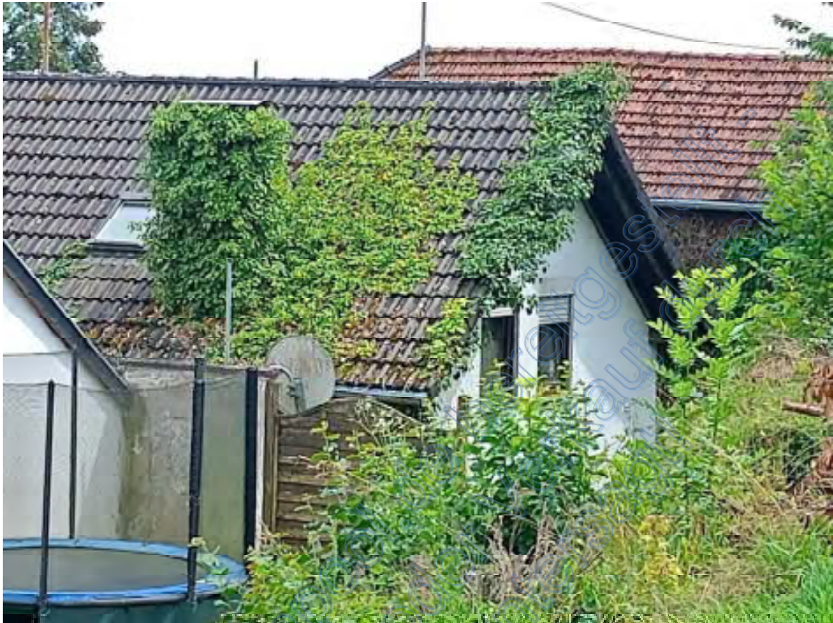
Abbildung 17 - Rückwärtiger Grundstücksbereich vom Parkplatz der "Alten Schule" in Augenschein genommen. Vegetation auf den Dachflächen und Bewitterungsspuren an der Gebäudehülle.
