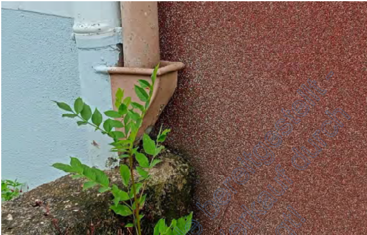
Abbildung 15 - Entwässerungssituation Gebäudeteil B mit Vegetation im gepflasterten Bereich
