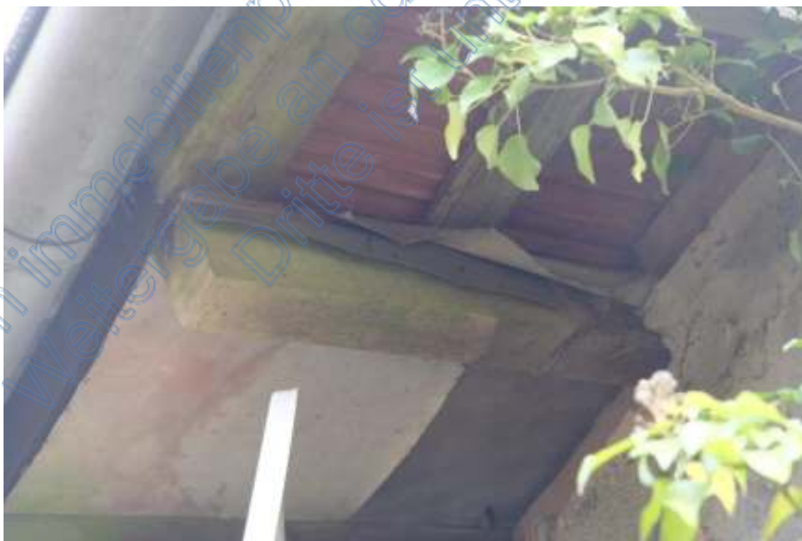
Dachgebälk schadhaft
