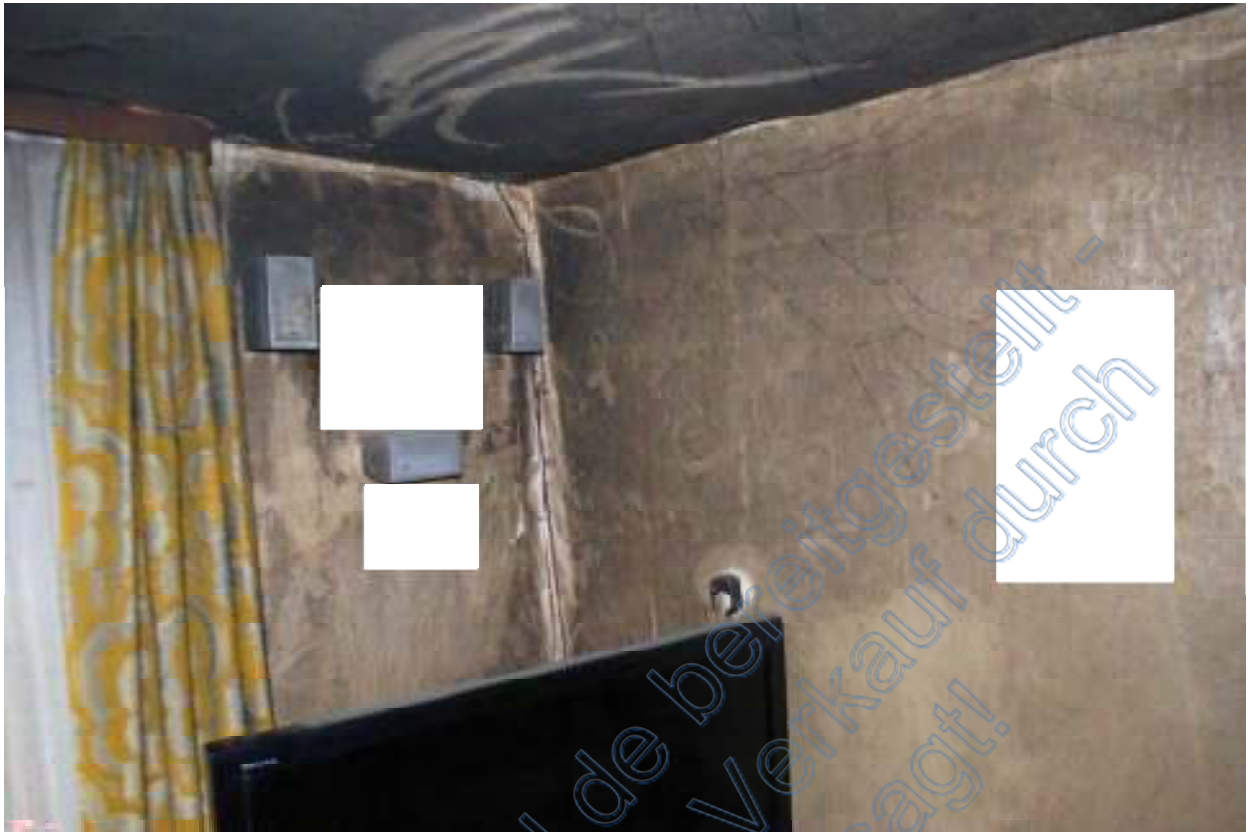
Starke Brandrückstände an Wänden und Decke (EG)
