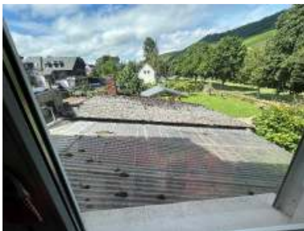
Überdachung Rückwärtiger Hauseingang
