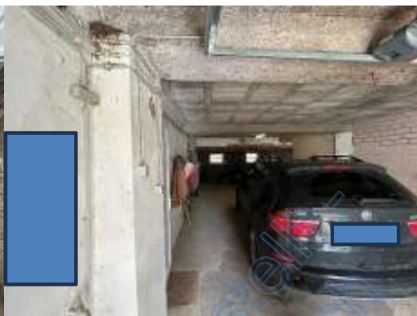
Garage Bild 2 (im Anbau)
