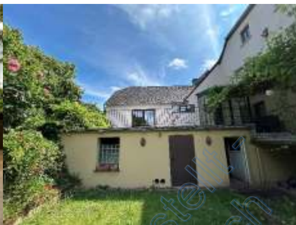
Tankraum (Gas), darauf Terrasse
