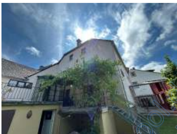
Rückansicht Haus, Terrassenüberdachung
