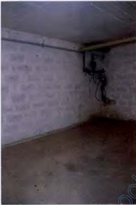
Innenansicht Keller mit Hausanschluss
