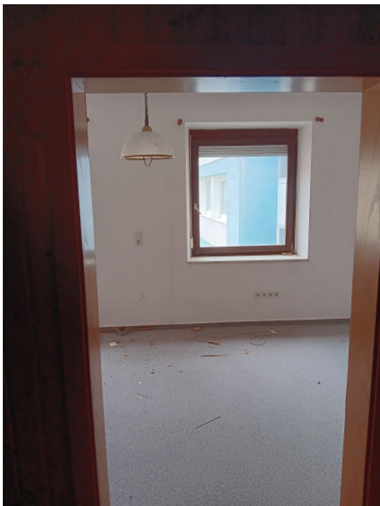
Zimmer (ehem. Büro)
