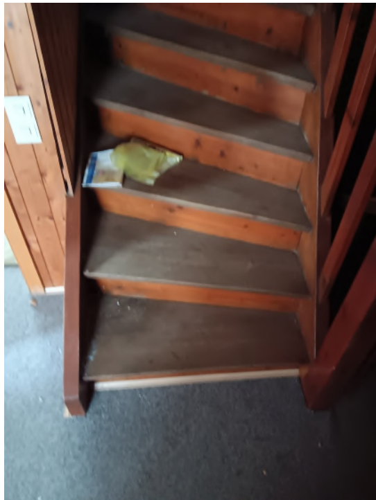
Flur 1. Obergeschoss mit Treppenaufgang zum Dachgeschoss
