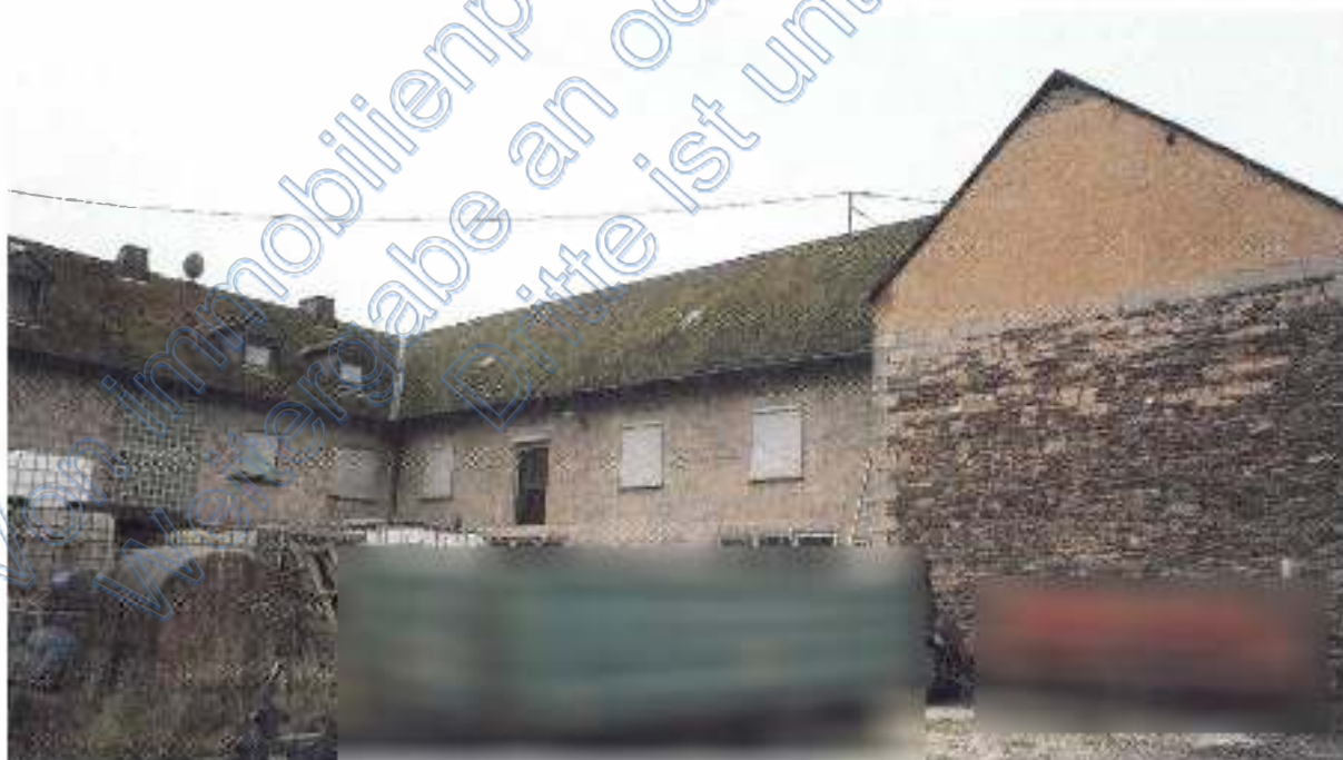
Außenansicht: Ansicht Nordost
