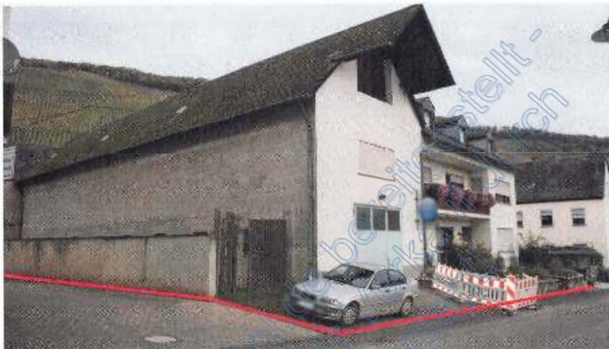
Außenansicht: Ansicht Südwest
