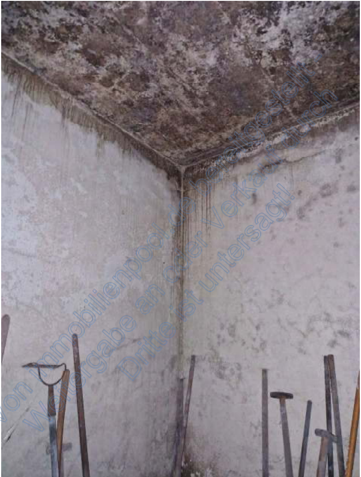
Erdberührte Außenwand im Erdgeschoss mit schwarzem Schadbelag. Deckenübergang in Terrassenbereich in den Garten.
