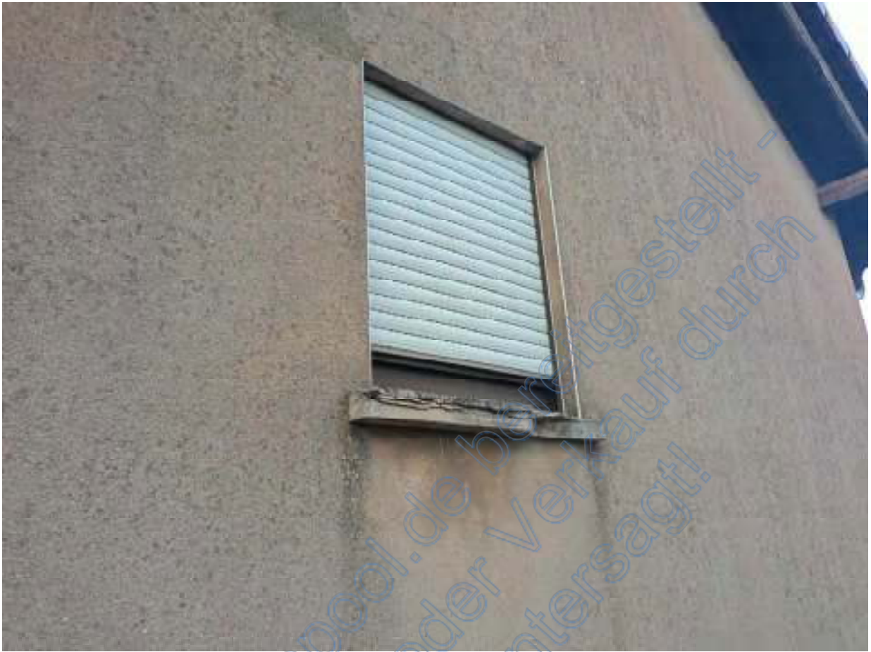
Fenster mit beschädigter Fensterbank
