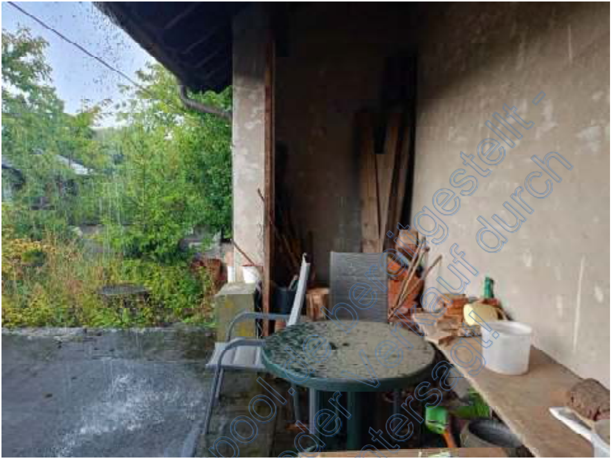
Unterkellertes Terrassenbereich (Feuchtigkeitsschaden im Geschoss unter Terrasse). Regenwasser wird von den verstopften Entwässerungssystemen des Dachs nicht mehr aufgefangen und fließt flächig über die Traufe. Exemplarisch für die meisten stichprobenhaft in augenschein genommenen Regenrinnen.
