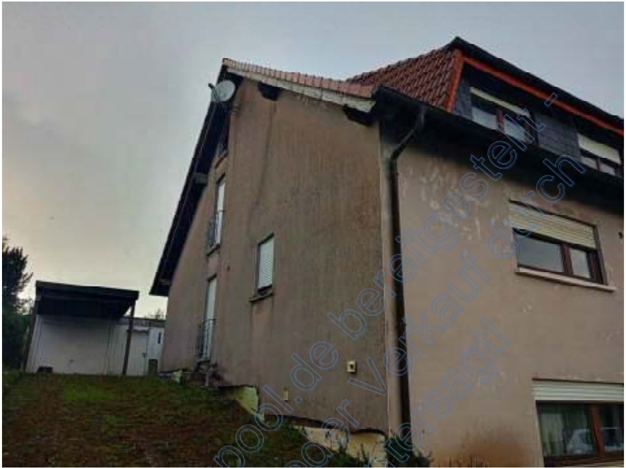
Blick von der grundstückseigenen Zufahrt auf das Bewertungsobjekt. Sichtbarer Instandhaltungstau an der nie vollständig fertiggestellten Fassade durch Bemoosung und Verwitterung.
