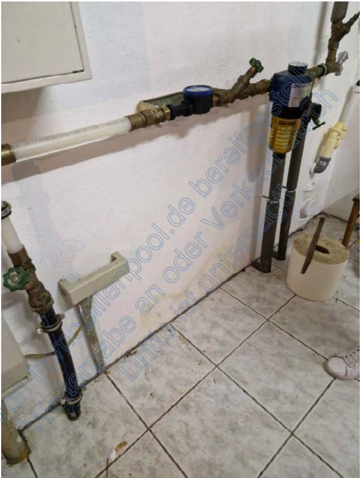
Feuchtigkeitsschaden im Erdgeschoss-Hausanschlussbereich
