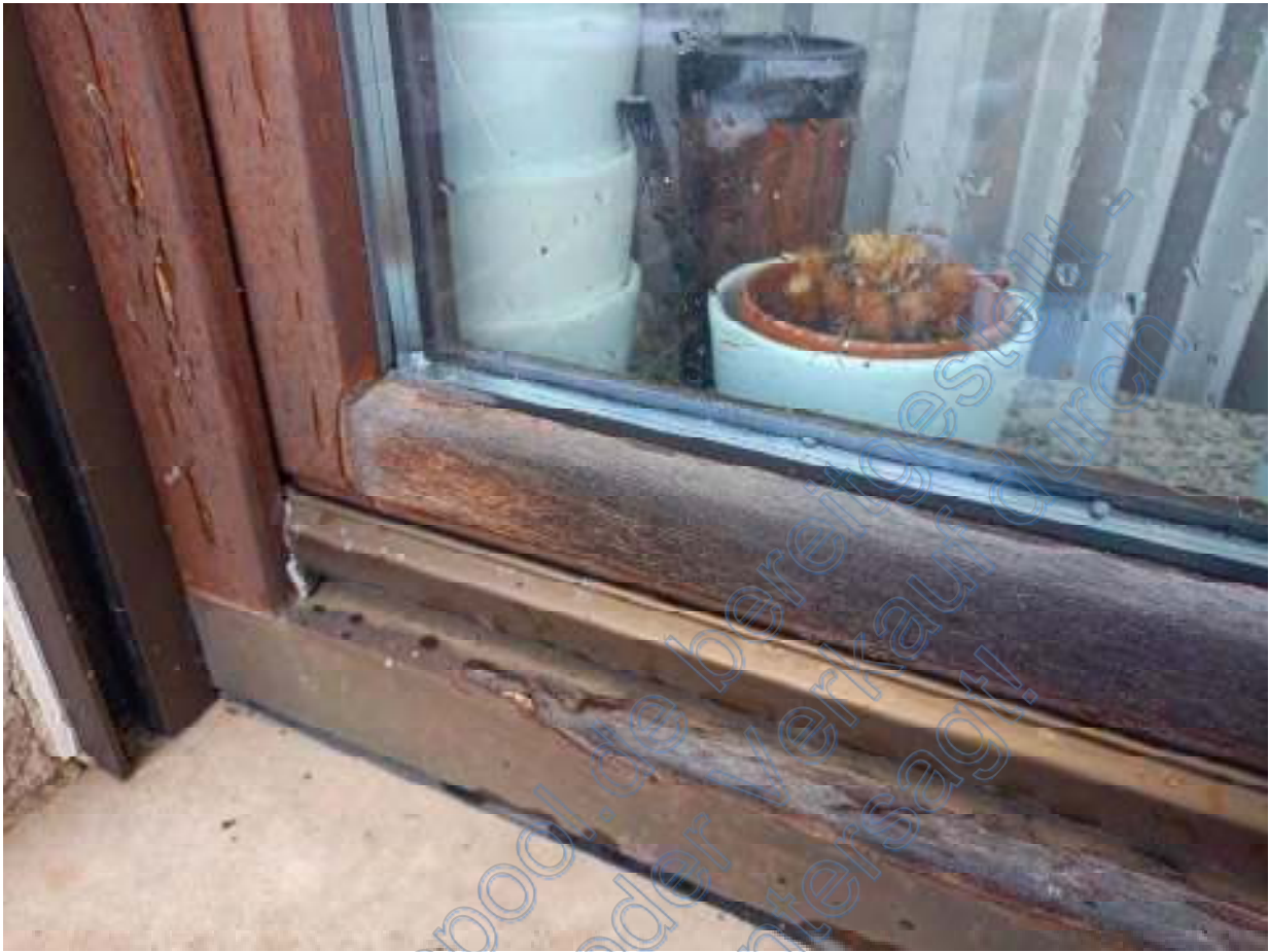
Beispielhafte Verwitterungsspuren an den Fenstern (ähnlich an den meisten Fenstern)
