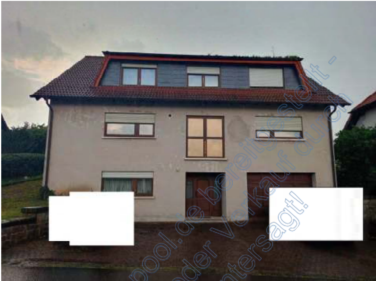
Blick von der Erschließungsstraße auf das Bewertungsobjekt. Sichtbarer Instandhaltungstau an der nie vollständig fertiggestellten Fassade durch Bemoosung und Verwitterung.
