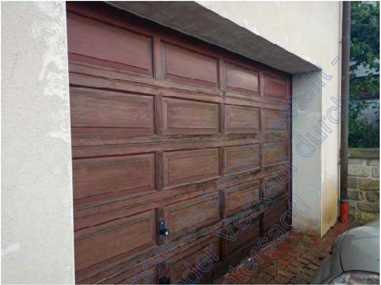
Tor zur Doppelgarage mit Bemoosung im Sockelbereich
