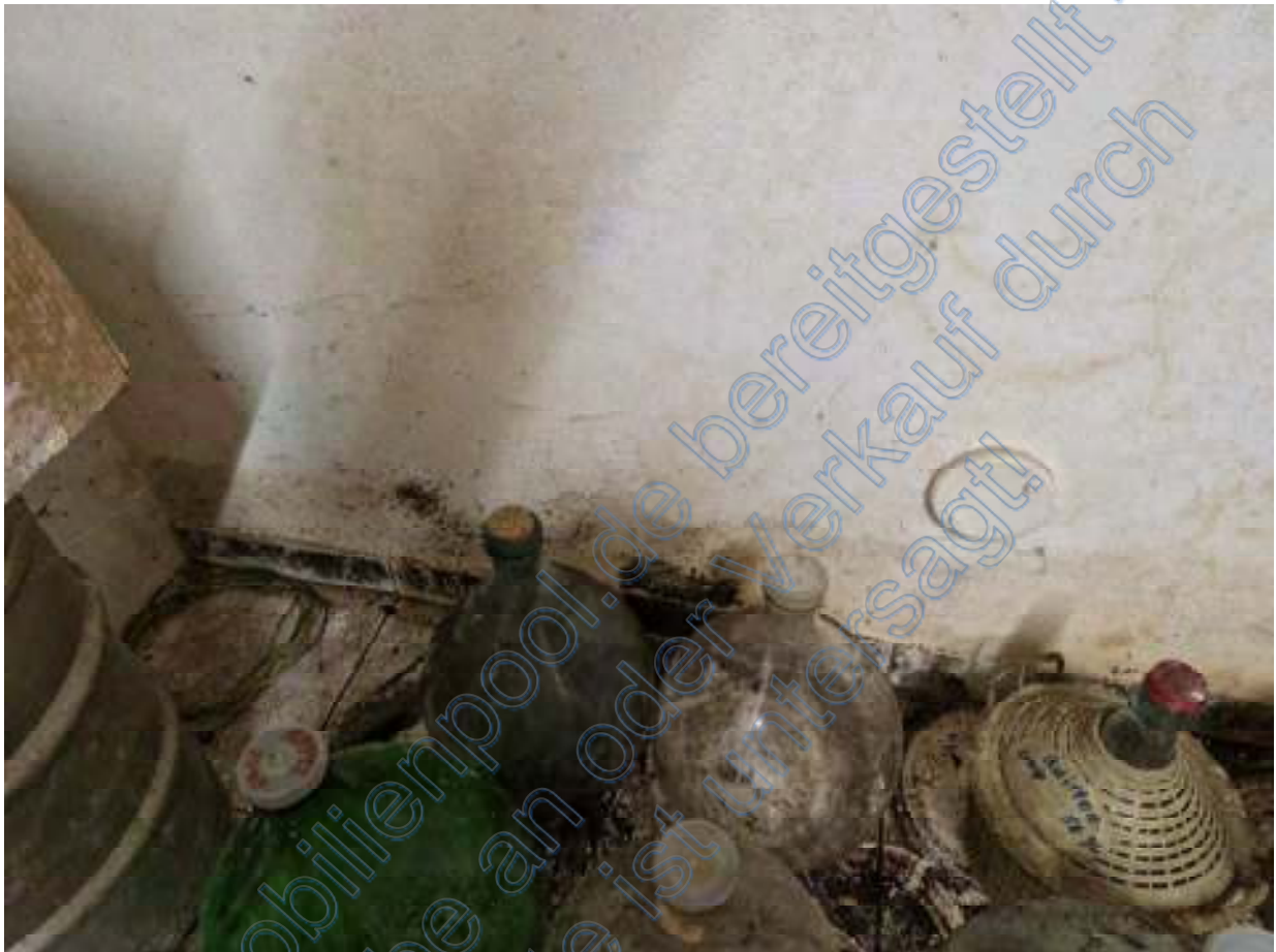
Erdberührte Außenwand im Erdgeschoss mit schwarzem Schadbelag
