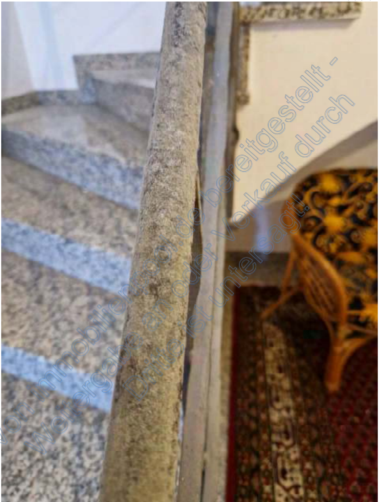
Verschimmelter Hausstaub auf dem Treppengeländer
