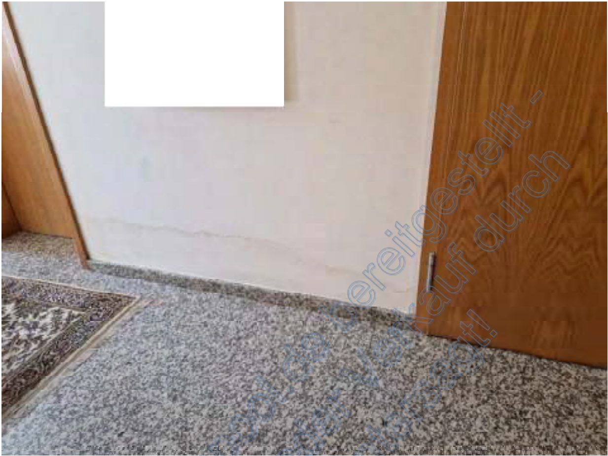
Feuchtigkeitsschaden im Erdgeschoss-Flurbereich
