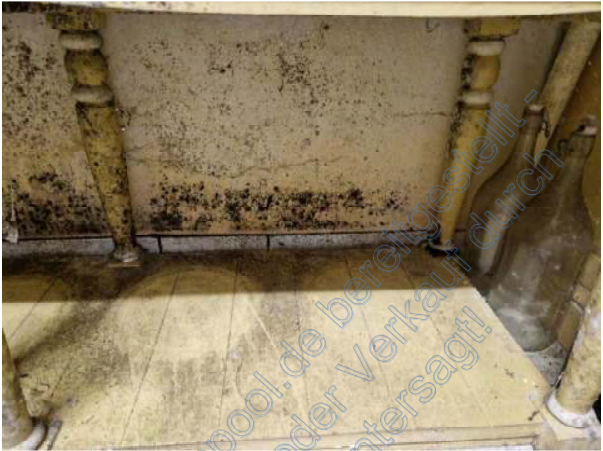
Wand im Abstellbereich im Erdgeschoss mit schwarzem Schadbelag
