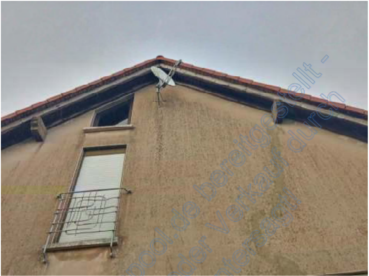
Ortgang mit Übergang zur First
