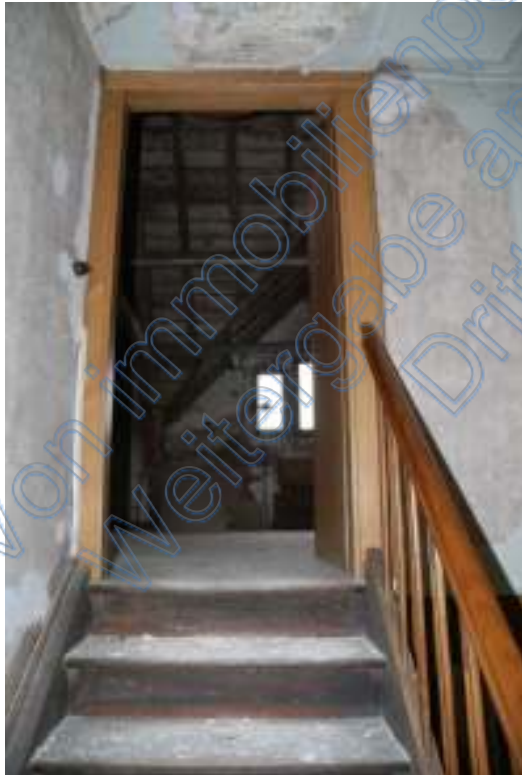
Detail Zugang zum Speicher
