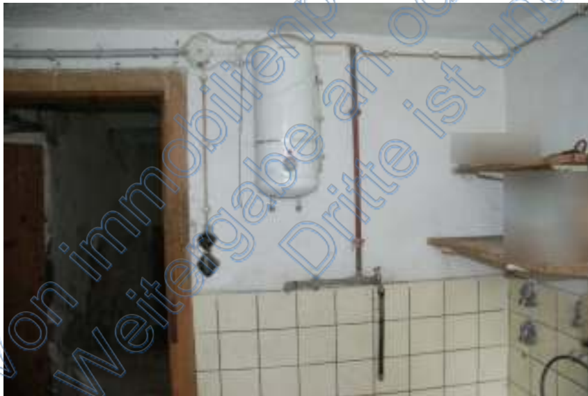
Detail Durchlauferhitzer
