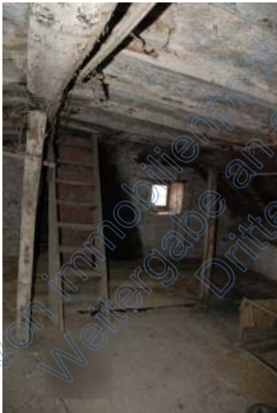
Innenansicht Speicher mit Holzstiege zum Spitzboden
