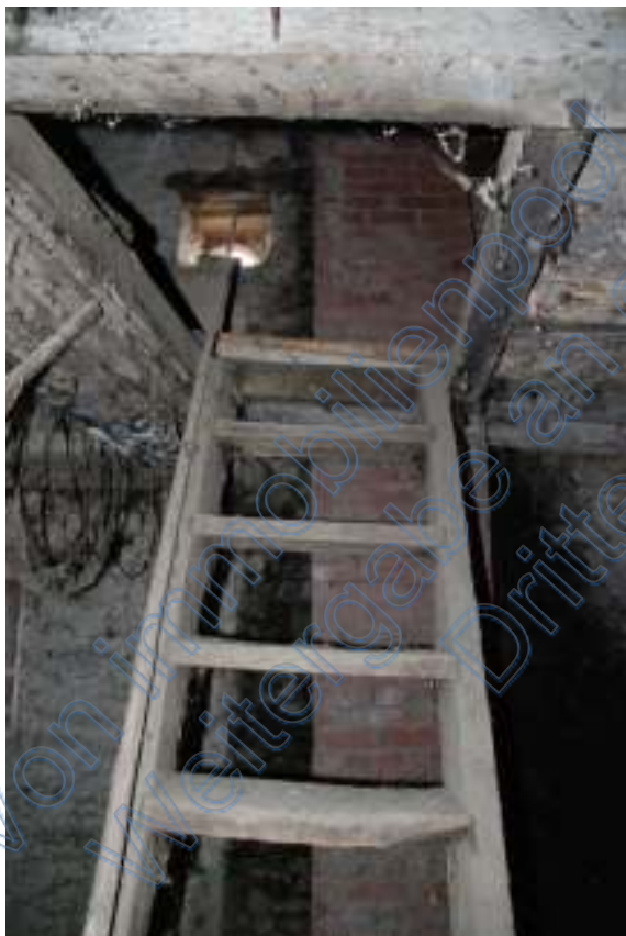
Detail Holzstiege zum Spitzboden
