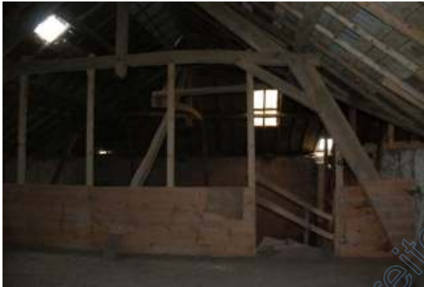
Innenansicht Lager, Detail Dachkonstruktion
