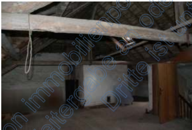
Innenansicht Speicher mit ehem. Räucherhaus
