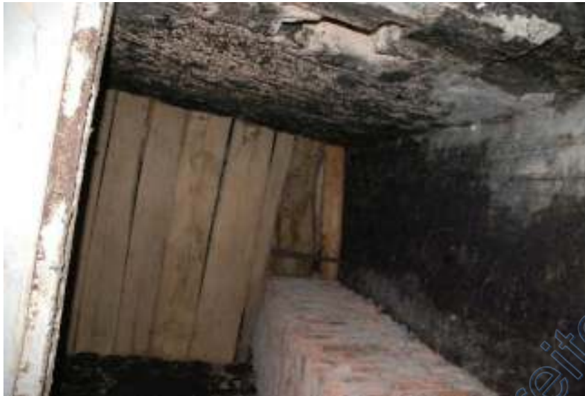
Detail Schacht in Decke bei Schornstein
