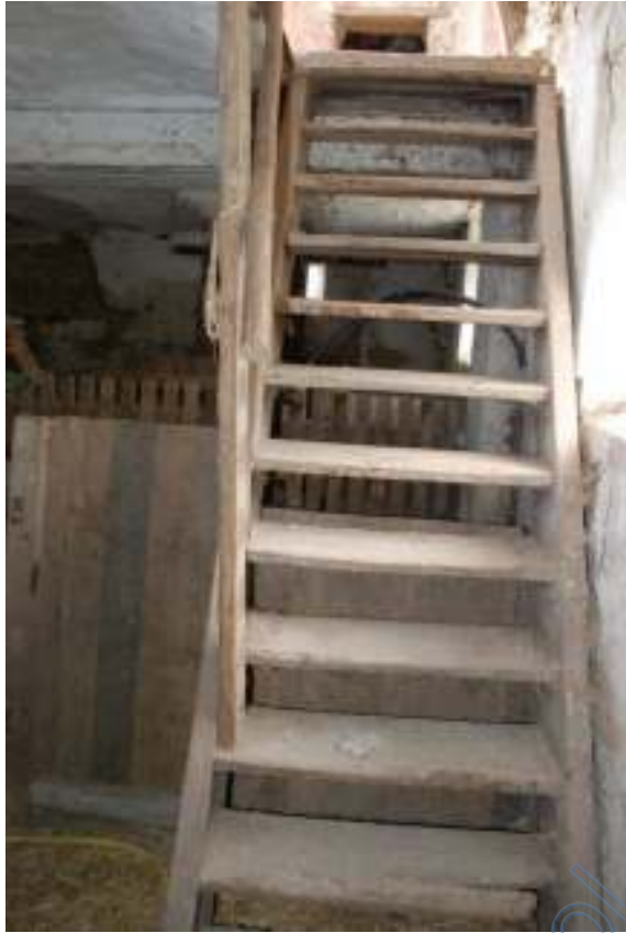
Detail Holzstiege zum OG
