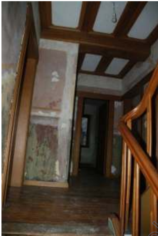
Innenansicht Treppenhaus OG
