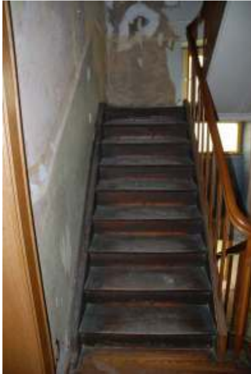
Detail Treppe zum DG
