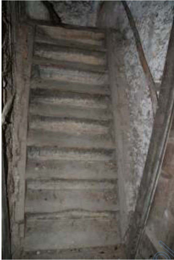
Detail Treppe zum DG
