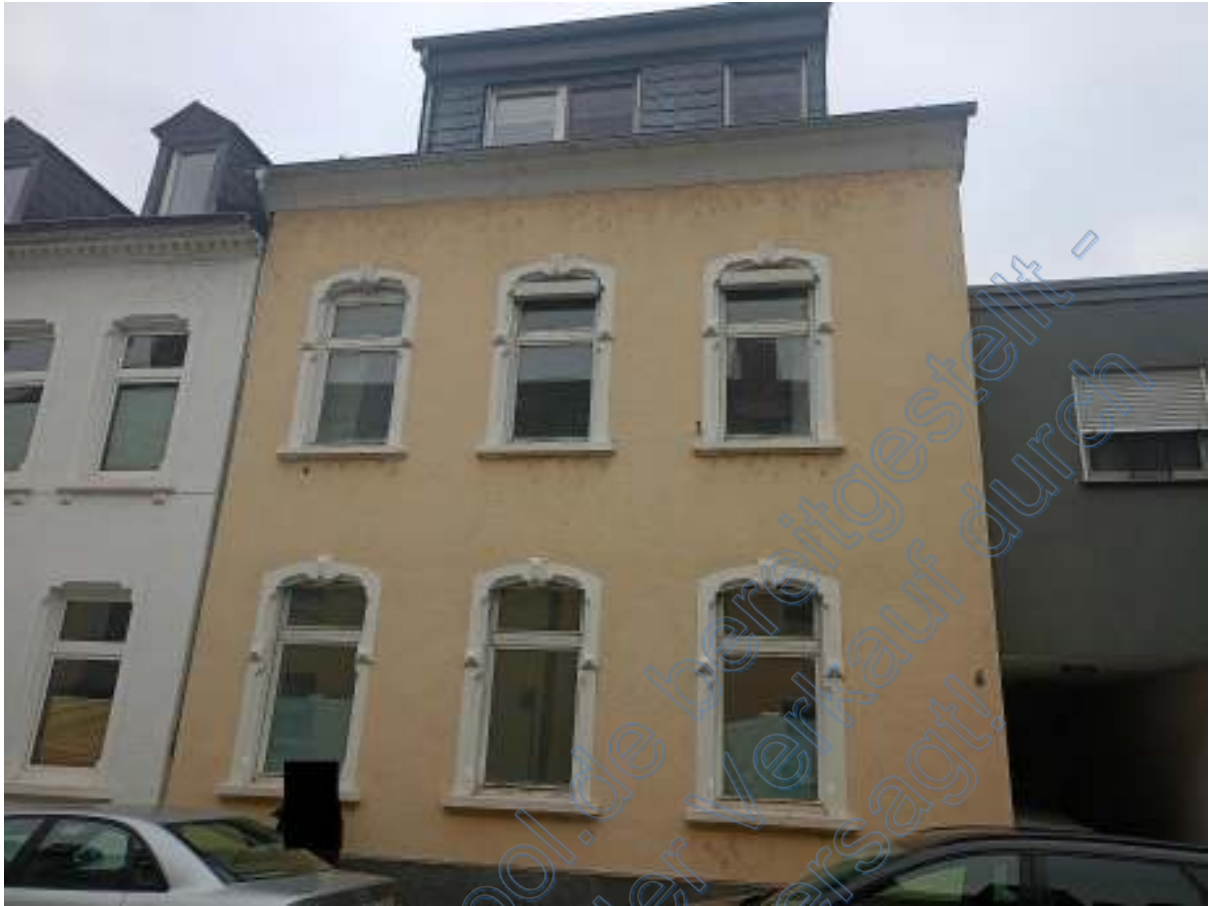
Abbildung 29 - der Straße zugewandte Hauptfassade
