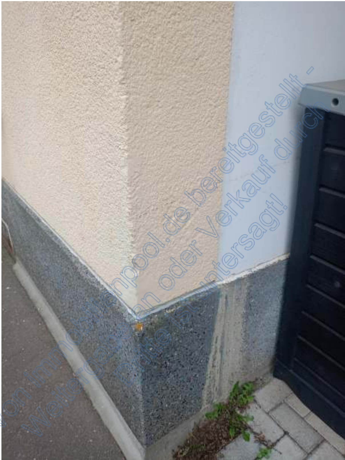
Abbildung 23 - Sockelbereich mit Bewitterungsspuren
