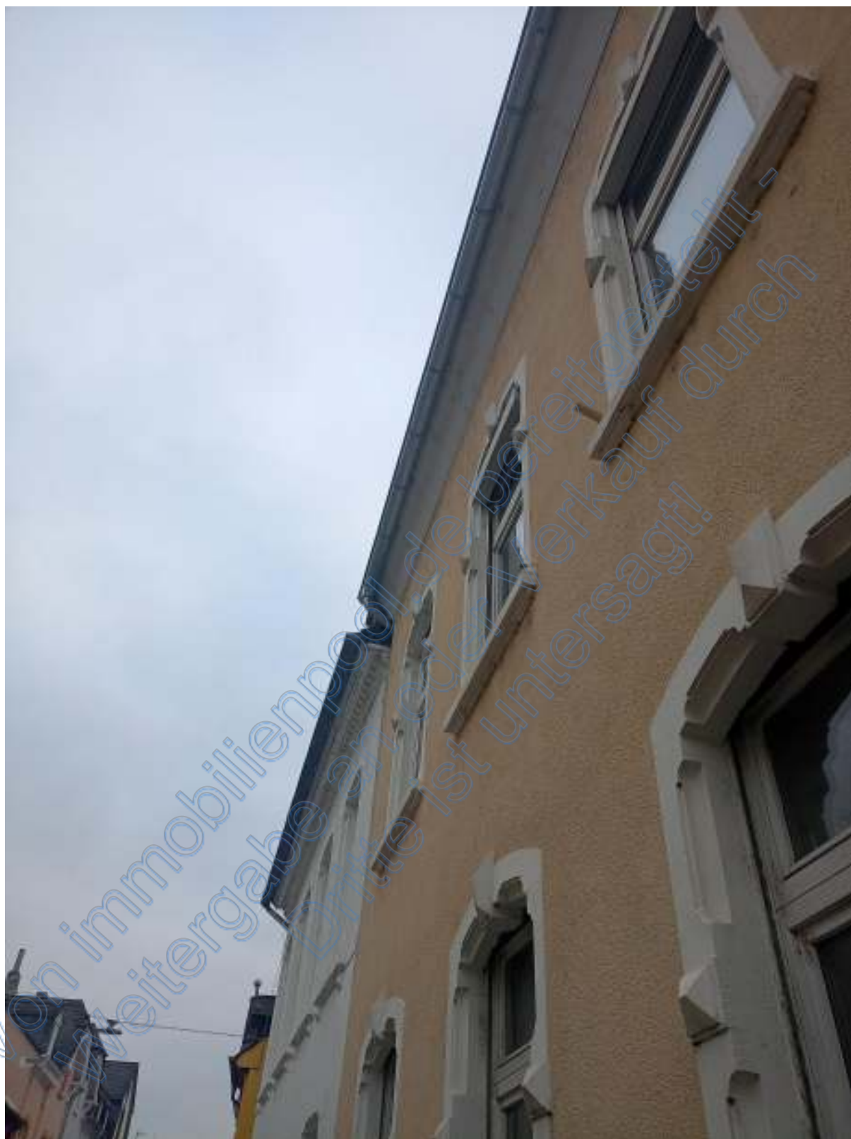
Abbildung 19 - Straßenfassade des Bewertungsobjekts in Häuserflucht
