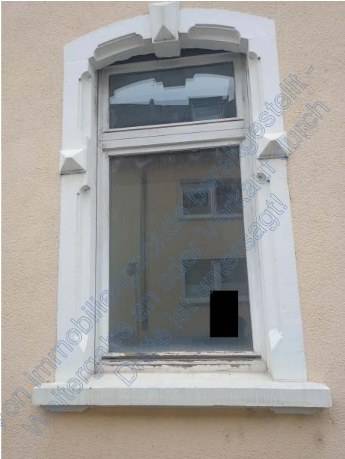
Abbildung 26 - exemplarisches Fenster der Fassade mit Faschen
