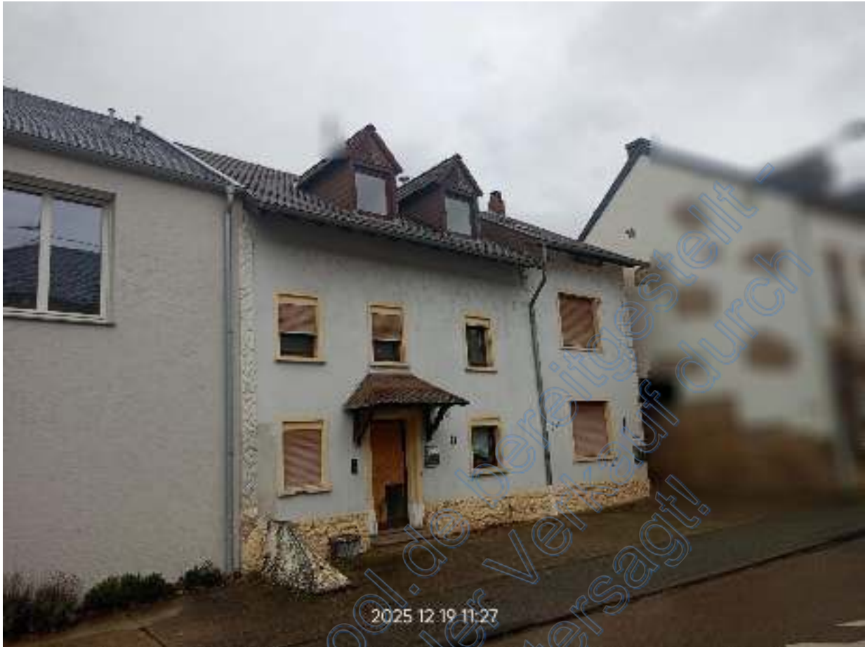
Straßenzugewandte Seite des Bewertungsgrundstücks im Zusammenhang mit der Nachbarbebauung.
