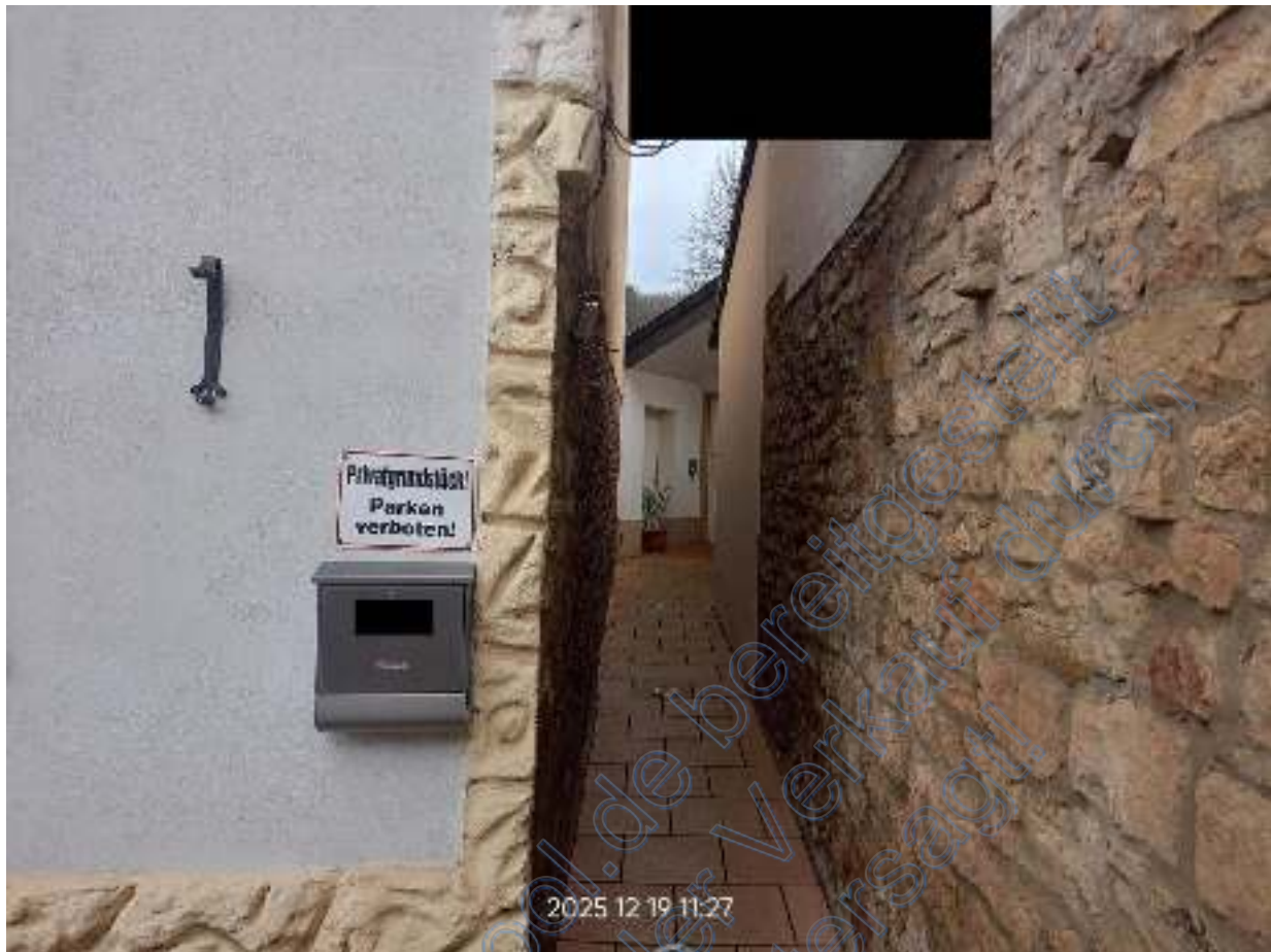
Zuwegung (über Wegerecht) auf dem Bewertungsgrundstück zum vorhandenen Überbau.
