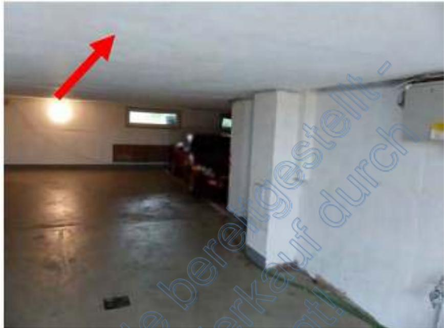
Deckenfläche mit Styropor gedämmt (Brandlast).
