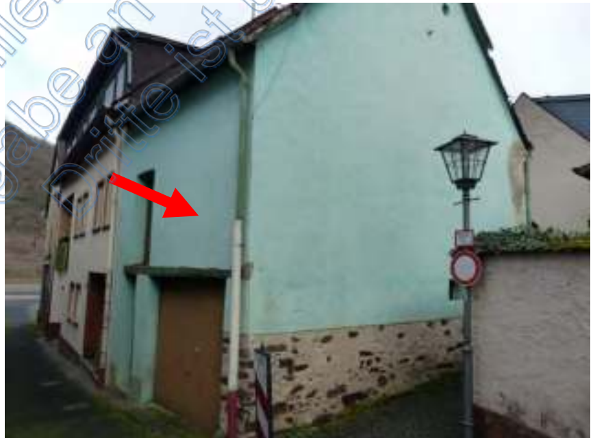
Ehemalige Scheune (PKW-Nutzung vermutlich nicht gegeben)
