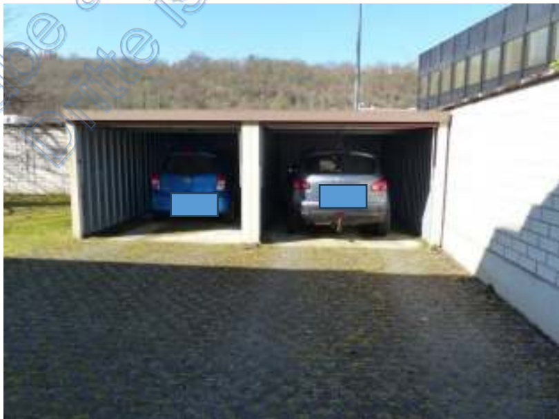
Doppelgarage in Metallkonstruktion
