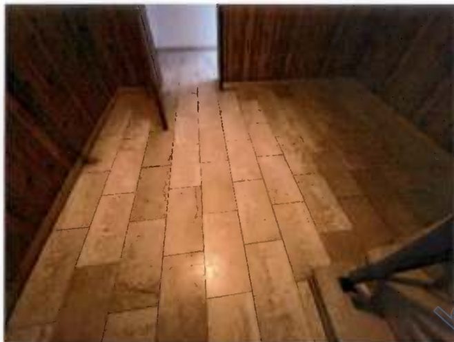
Treppenhausflur vor Kellerräumen
