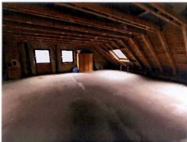
Dachboden mit Ausbaupotenzial
