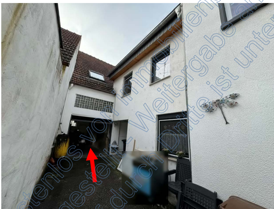
Ehemalige Scheune (siehe Pfeil)
