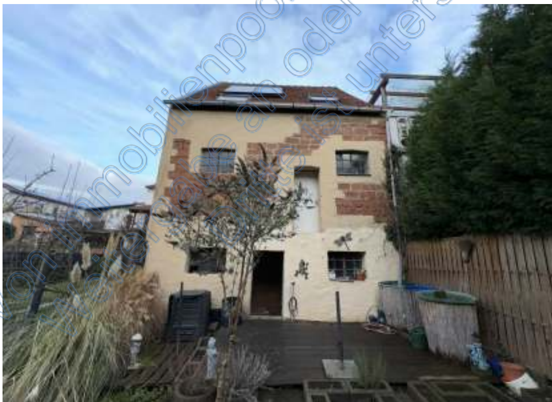
Gartenansicht (ehemalige Scheune)
