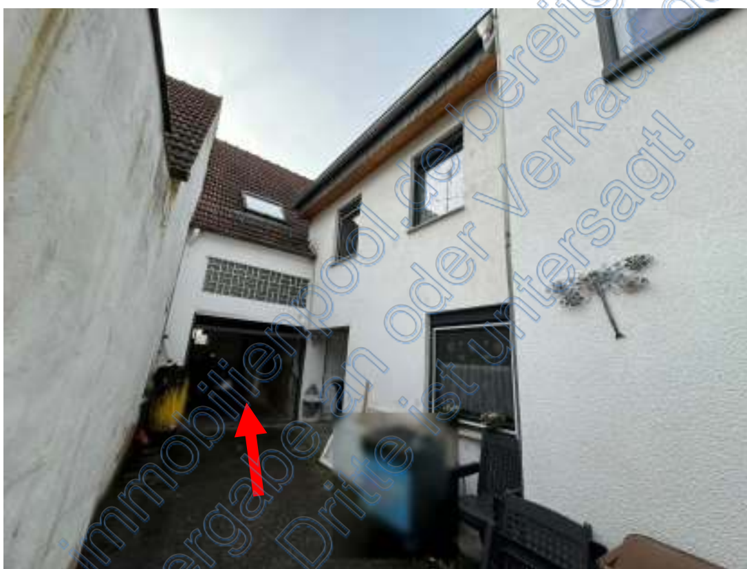
Ehemalige Scheune (siehe Pfeil)
