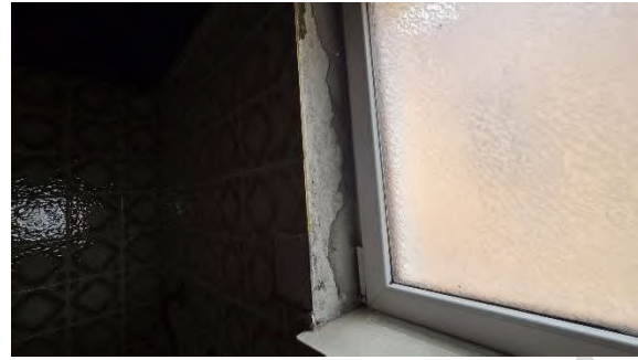
50 Fenster und Fensterbank
