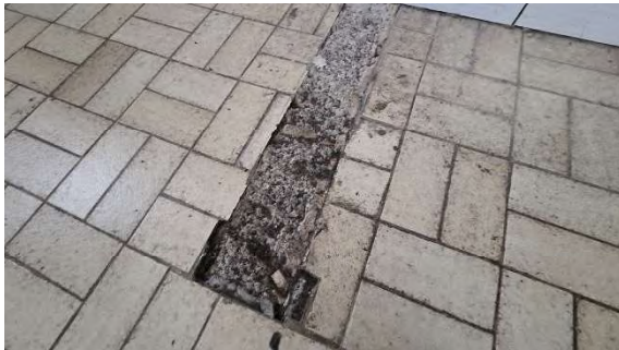
45 Bodenbelag Bad (OG)
