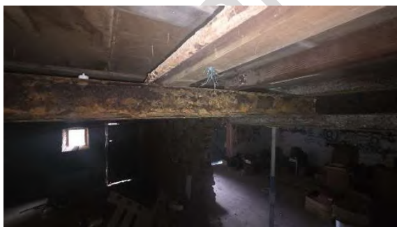
57 korrodierter Stahlträger
