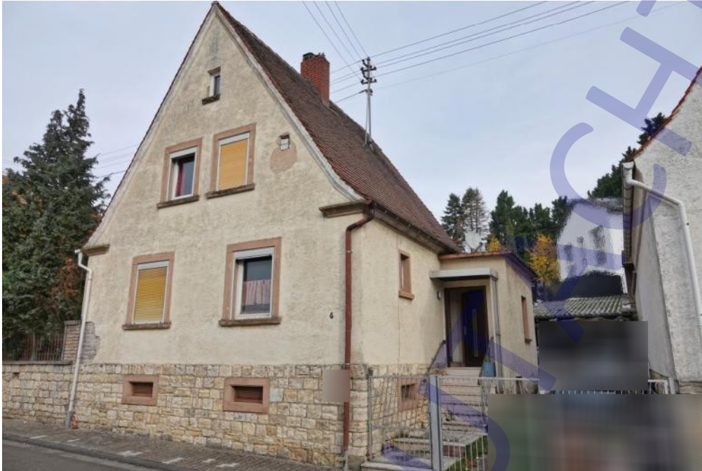
BILD 01 ANSICHT SÜD - STRAßENANSICHT, ZUGANG & ZUFAHRT -
