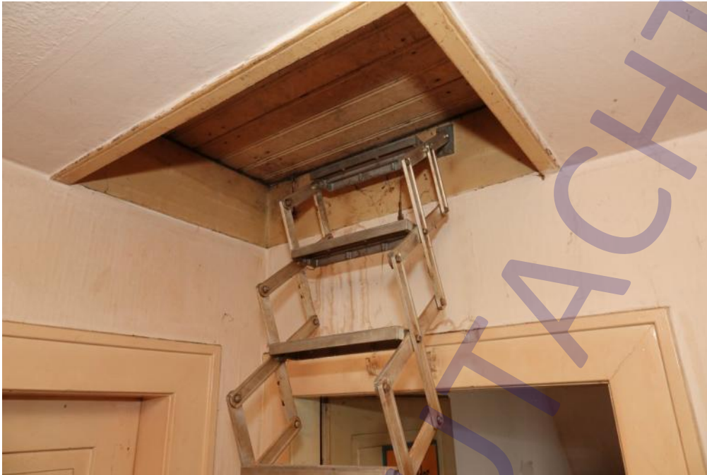
BILD 13 INNENANSICHT DACHGESCHOSS - LUKE ZUM DACHSPITZBODEN (NUR BEDINGT EINSEHBAR) -
