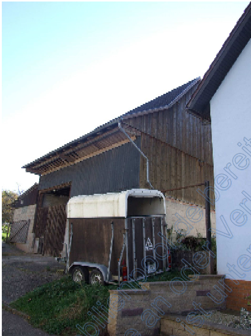
SCHEUNE GIEBELSEITE NORDWESTEN
