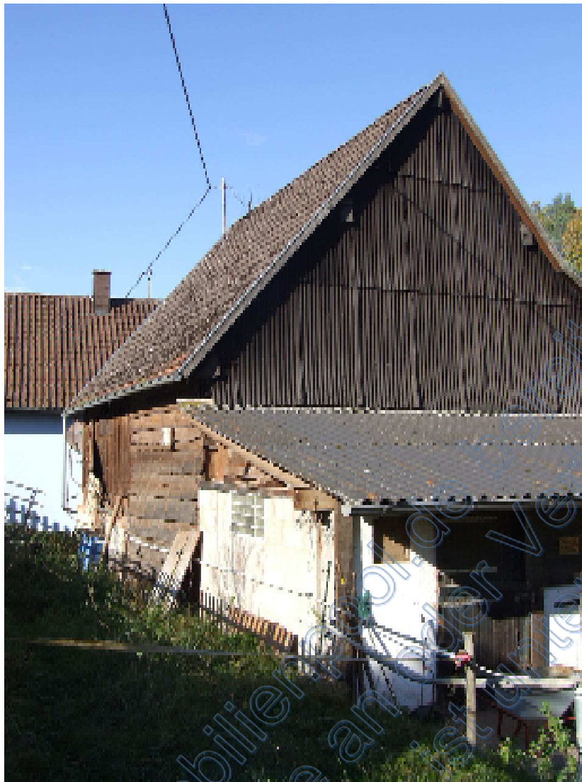
RÜCKSEITE UND GIEBEL SÜDWEST, SÜDOSTEN
