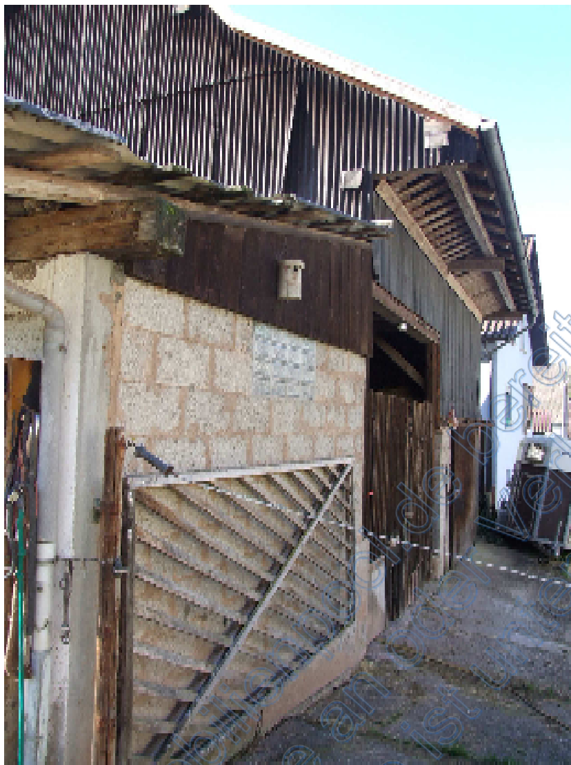
STALL UND GIEBEL SCHEUNE SÜDOSTEN
