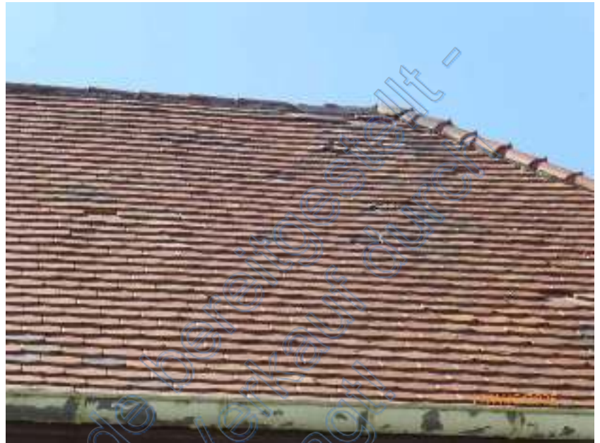
schadhafte Dacheindeckung
