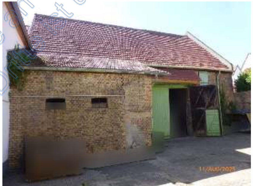
Ansicht von Osten, Scheune
