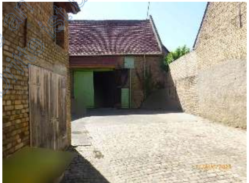
Ansicht von Osten, Scheune
