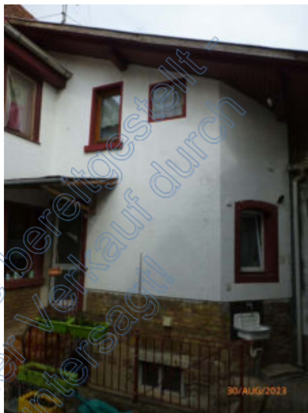
Ansicht von Westen, Hofseite
