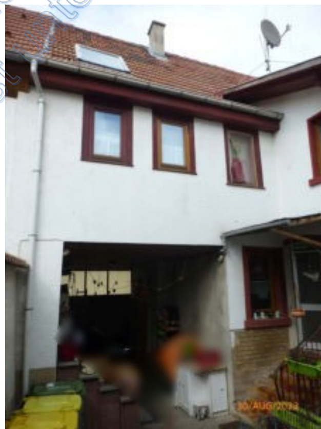
Ansicht von Süden, Hofseite
