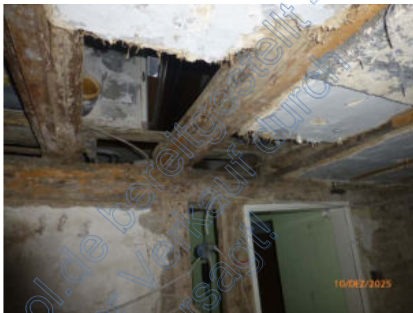
Innenansicht Wasserschaden
